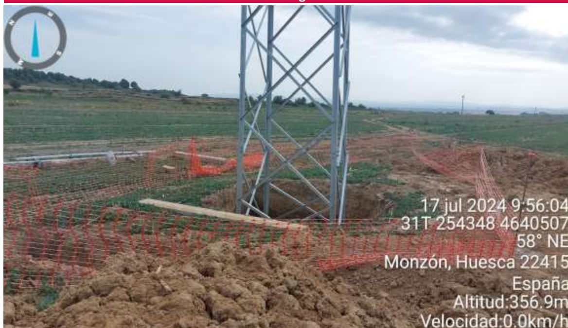
Imagen 1. Apoyo 24 LAT SC1 posicionado a falta de nivelar.
