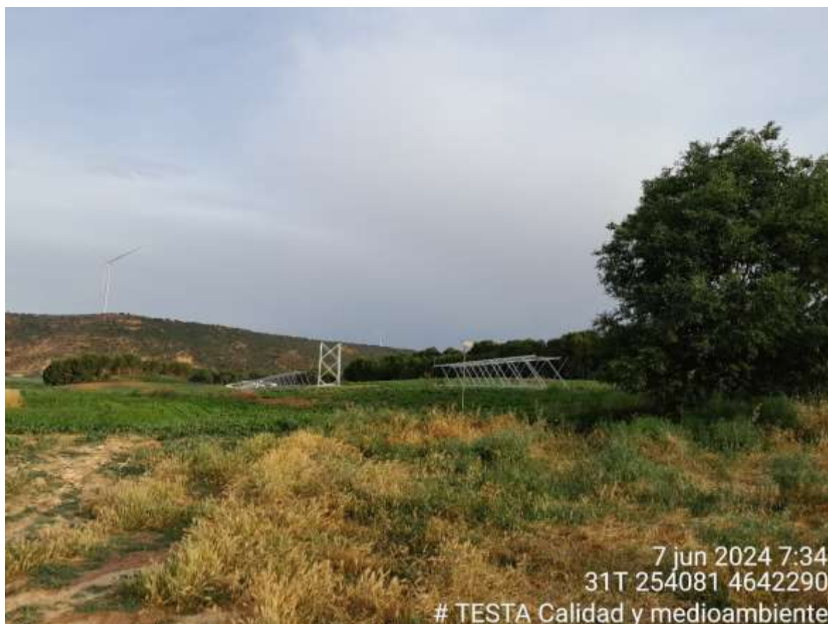
Imagen 1. Apoyo de la LAT SC4
