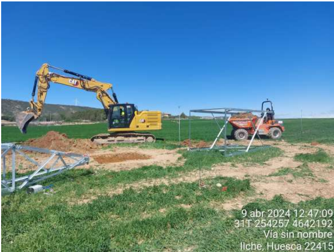
Imagen 1. Trabajos de excavación en el apoyo 10 de la LATSC4-Armentera
