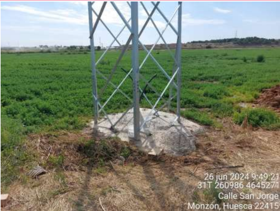
Imagen 1. Apoyo hormigonado y montado parcialmente.
