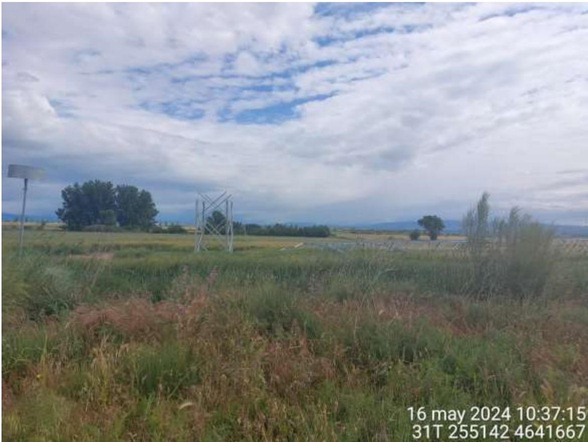
Imagen 1. Apoyo 12 LAT SC4.
