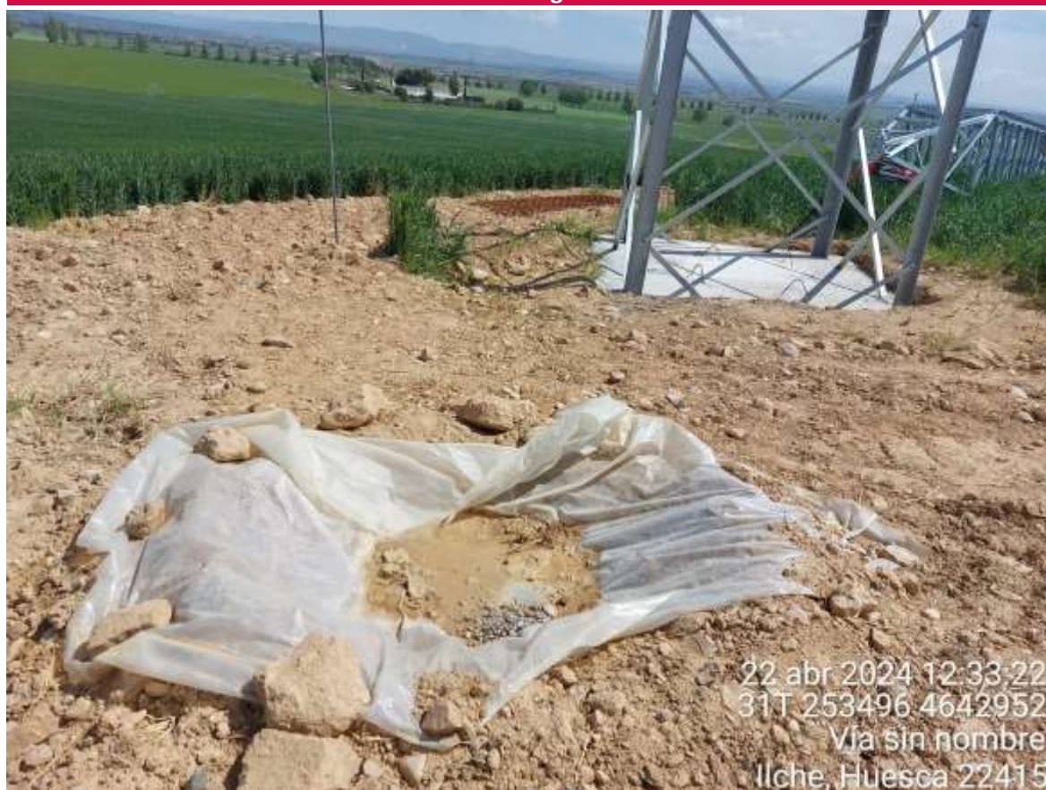
Imagen 1. Apoyo de LATSC4-Armentera hormigonado con las medidas preventivas indicadas.
