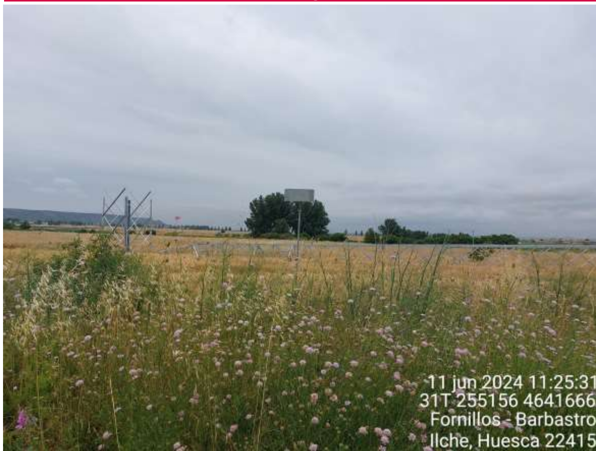
Imagen 1. Apoyo de la LAT SC4 pendiente de ser montado.
