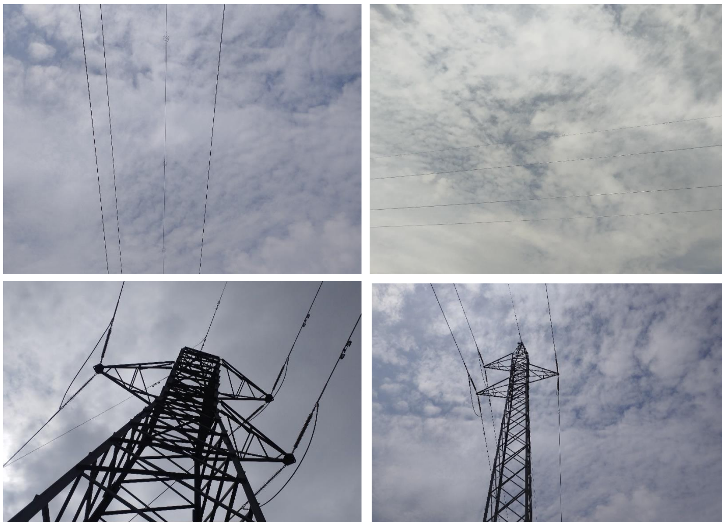
Fotografías 5 a 8: Tendido con salvapájaros y apoyos de celosía
