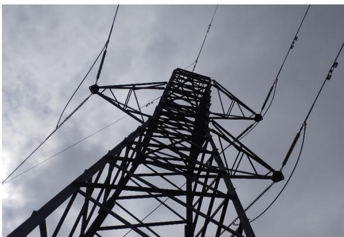
Fotografías 5 a 8: Tendido con salvapájaros y apoyos de celosía
