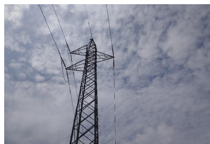
Fotografías 5 a 8: Tendido con salvapájaros y apoyos de celosía
