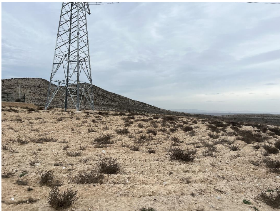
Fotografía 3: Estado de la revegetación natural SET Fuentes (sept-nov 2023)
