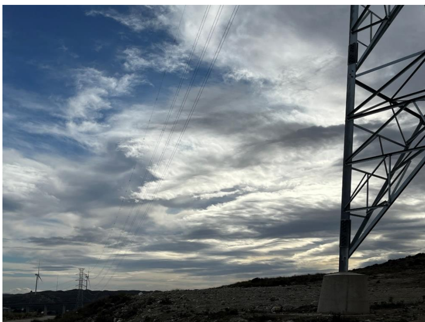
Fotografía 2: Vegetación natural en la plataforma de los apoyos al inicio de la implantación
