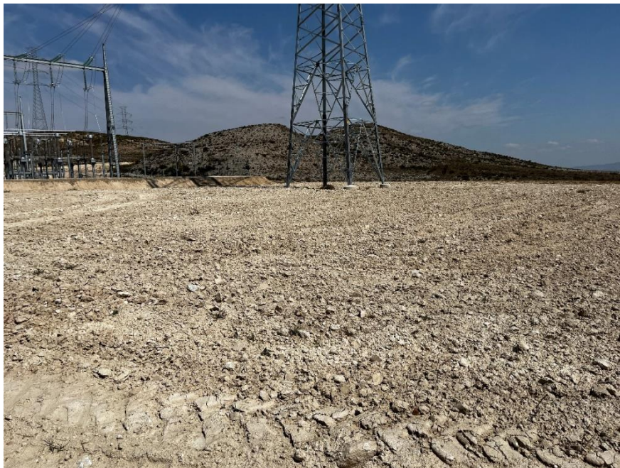
Fotografía 1: Vegetación natural en el inicio de la implantación
