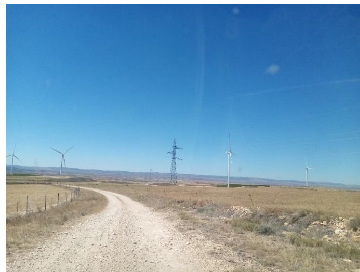
Fotografía 3 y 4: Tendido y al fondo parque eólico
