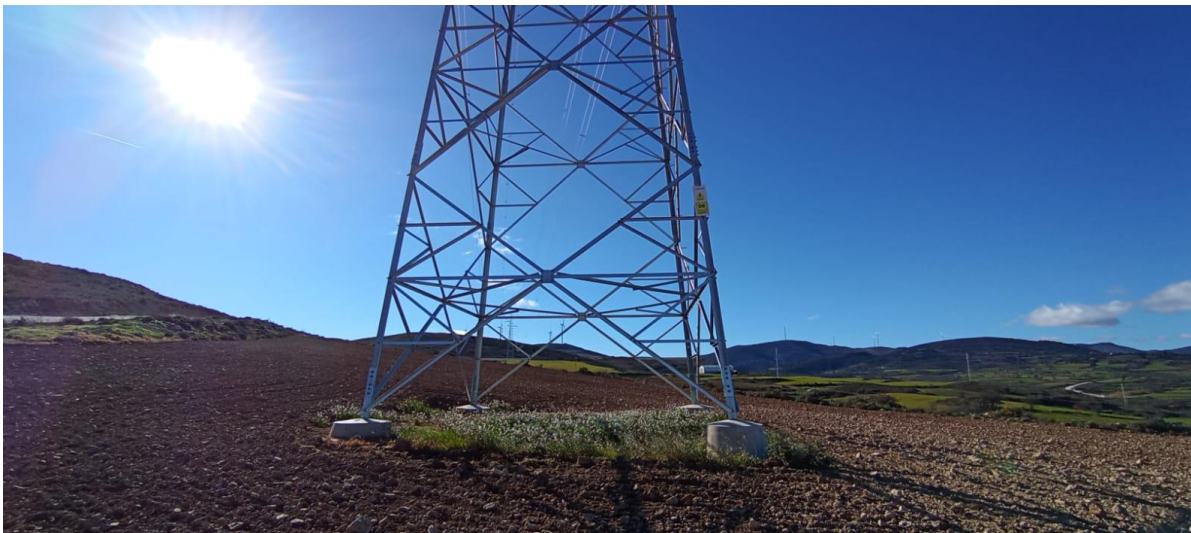
Fotografías 3 y 4: Apoyos tipo metálico de celosía
