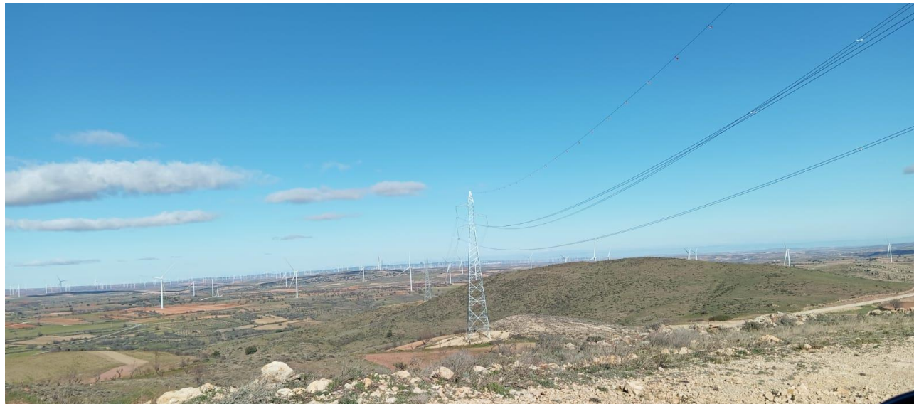
Fotografías 1 y 2. Visibilidad de la línea eléctrica
