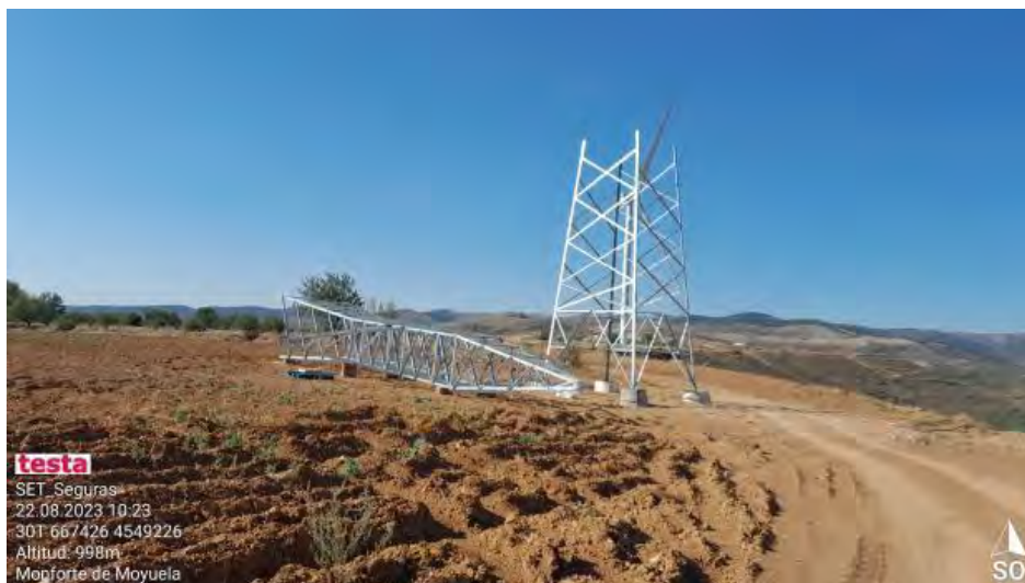
Montaje de apoyo.
