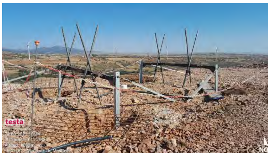
Nueva cimentación en LAT Seguras AP-4.
