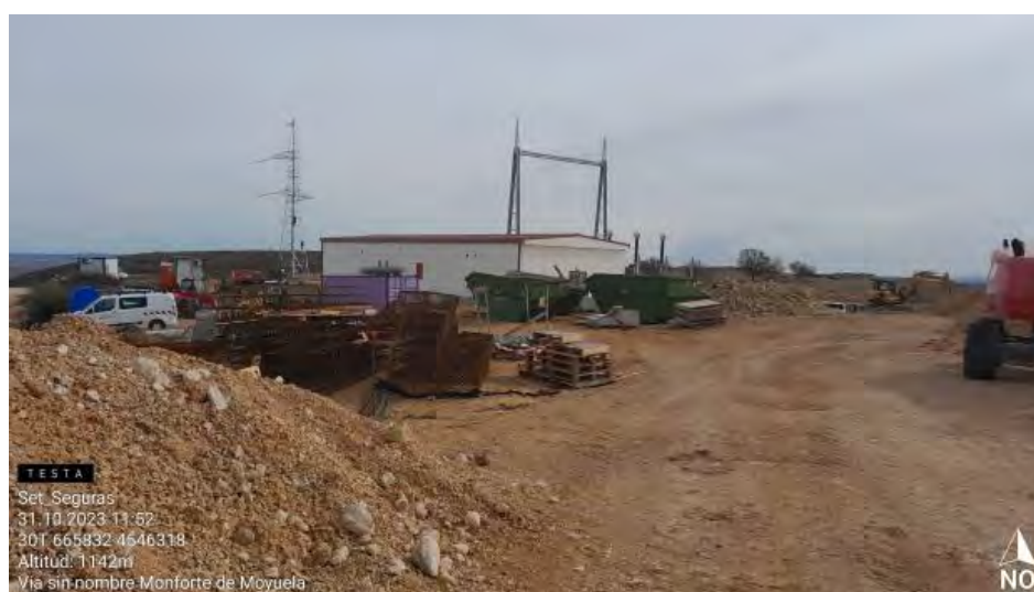
Punto limpio SET Seguras
