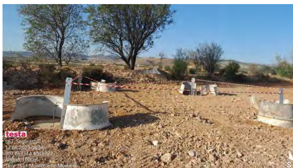
Nueva cimentación en LAT Seguras.
