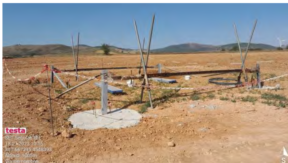
Hormigonado de cimentación de apoyo , correcto.
