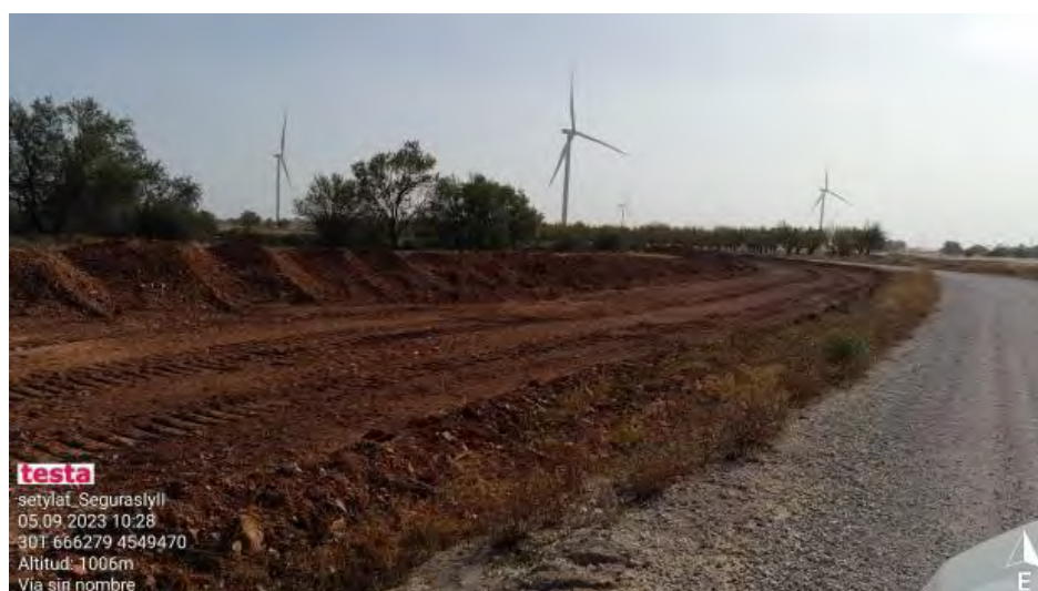
Zanja de evacuación en SET Monforte.
