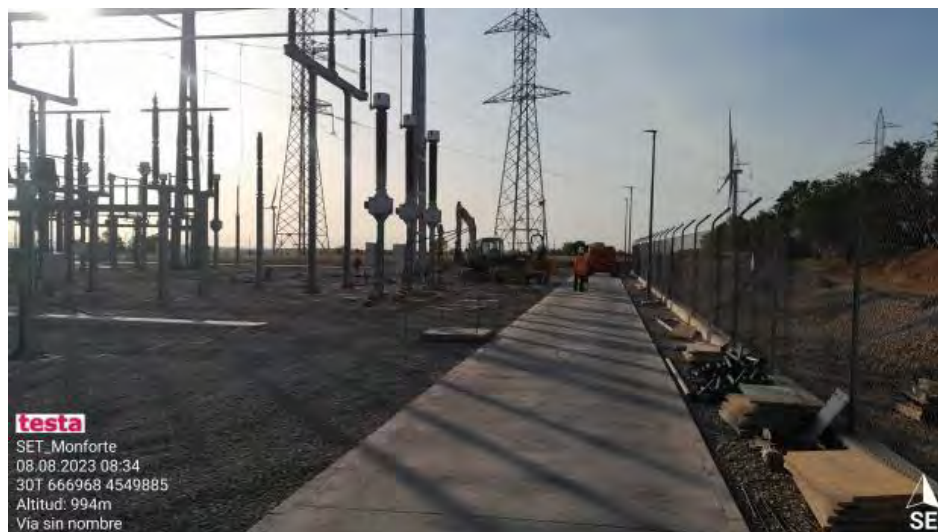
Trabajos en SET Monforte
