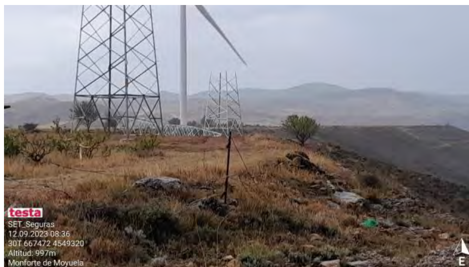
Montaje de apoyo.
