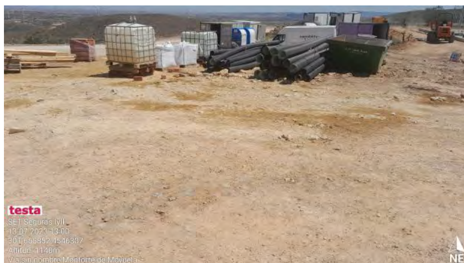
Manchas de residuos frente a contenedores RNP.
