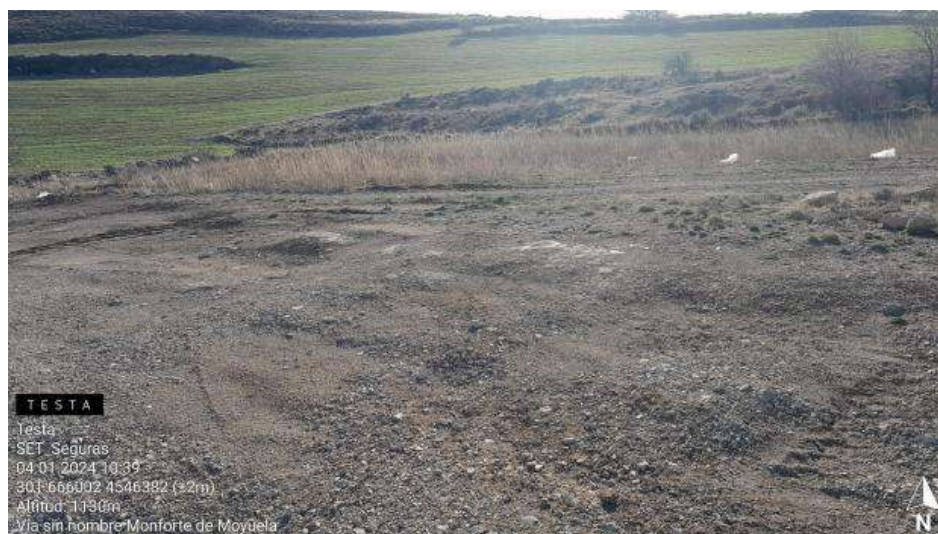
Zona con residuos alrededor de apoyo 01
