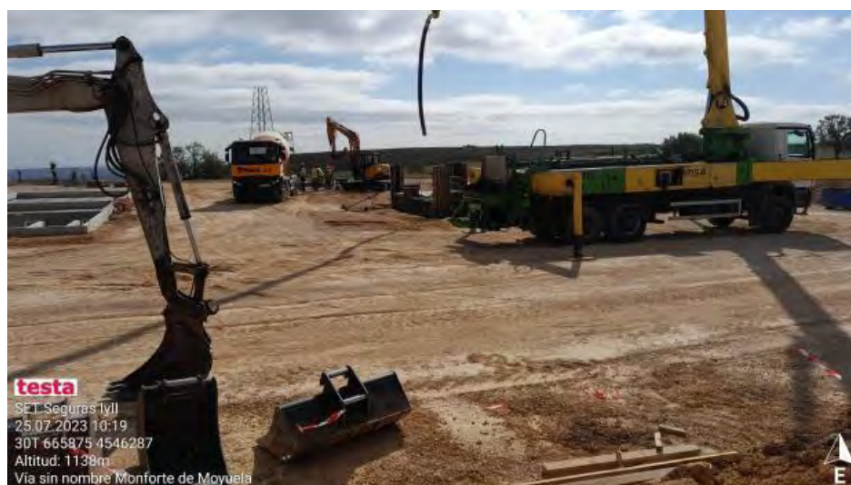
Hormigonado durante la visita en SET Seguras.
