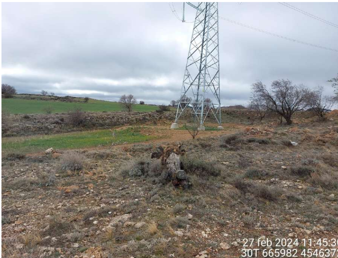
Apoyo nº 1 de la línea eléctrica
