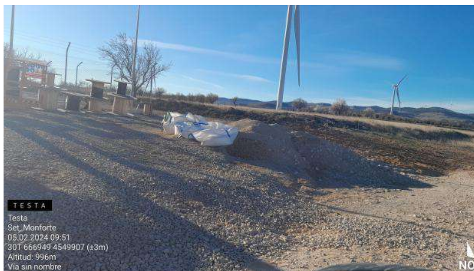
Retirada de contenedores en SET Monforte.
