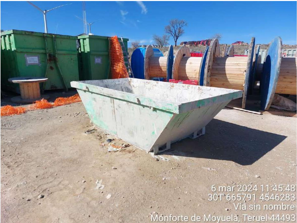
Contenedores y bobinas en campa Set Segura
