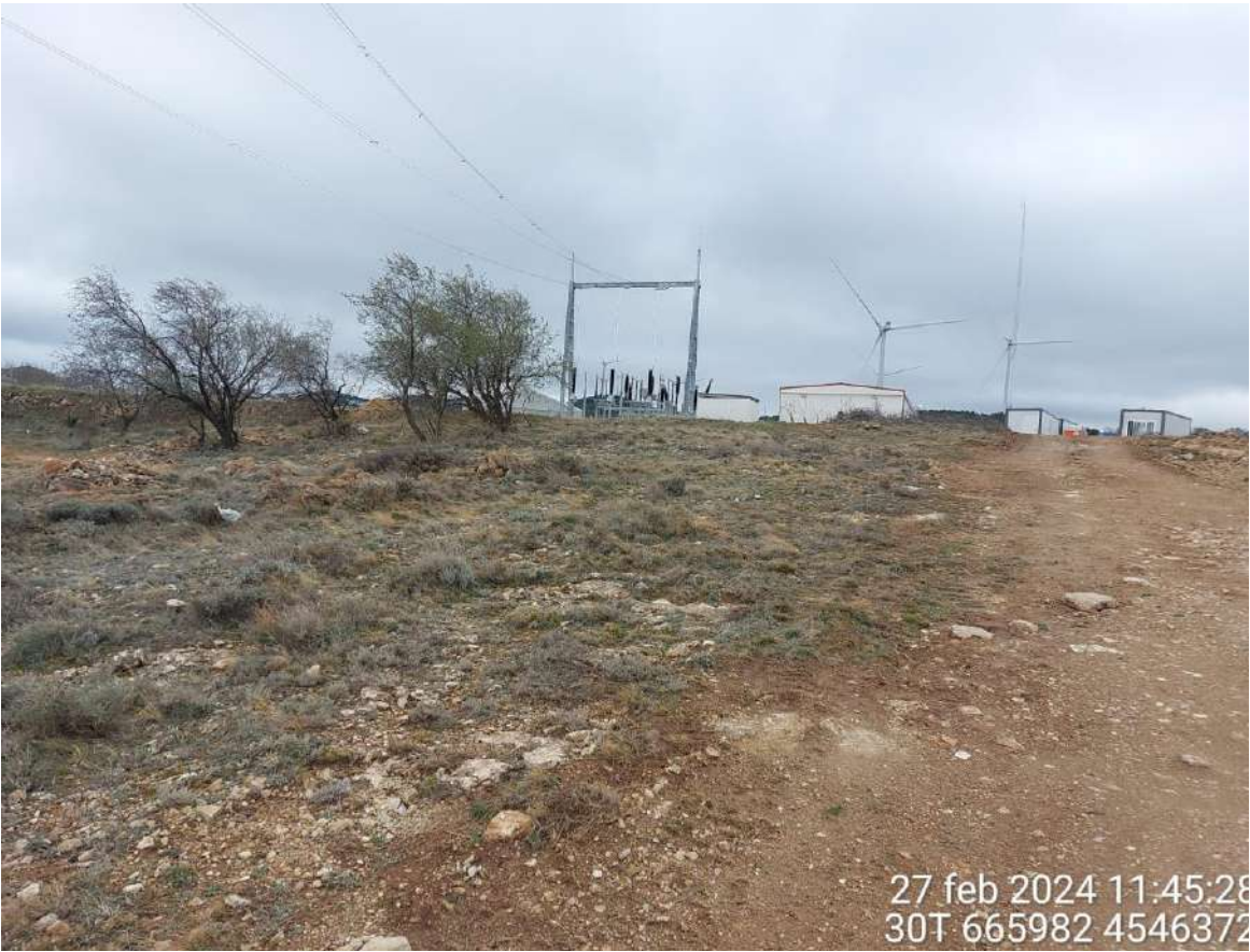
Subestación, línea eléctrica y parque eólico
