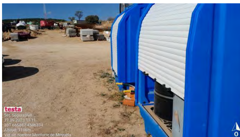
Contenedor RP sin cerrar
