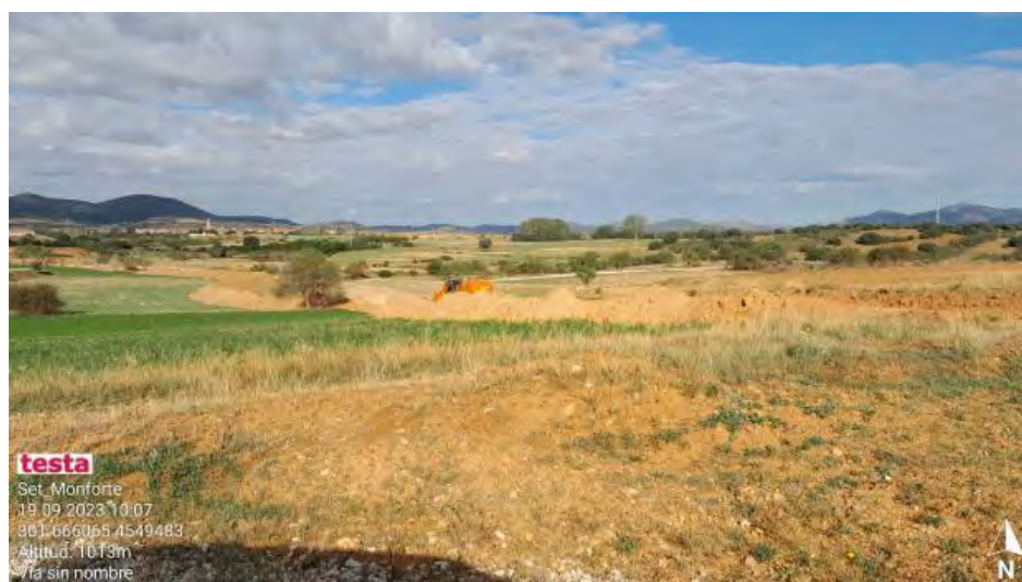
Zanja de evacuación en SET Monforte.
