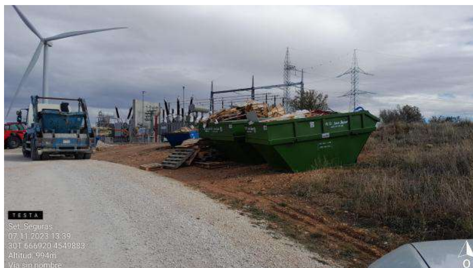
Punto limpio en SET Monforte
