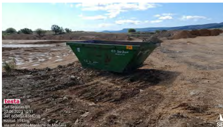
Contenedor de RNP en SET.
