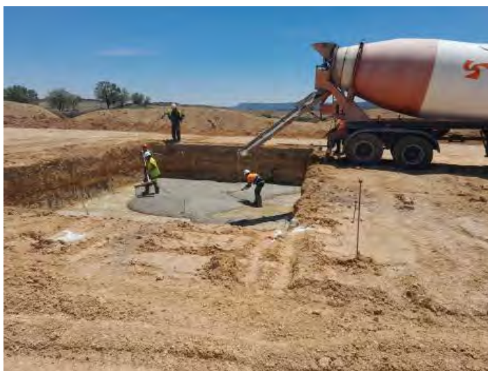
Hormigonado de limpieza en SET Seguras
