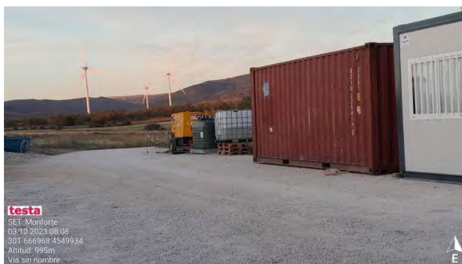
Localización de generador y depósito provisional
