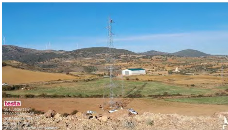
Montaje de apoyo.
