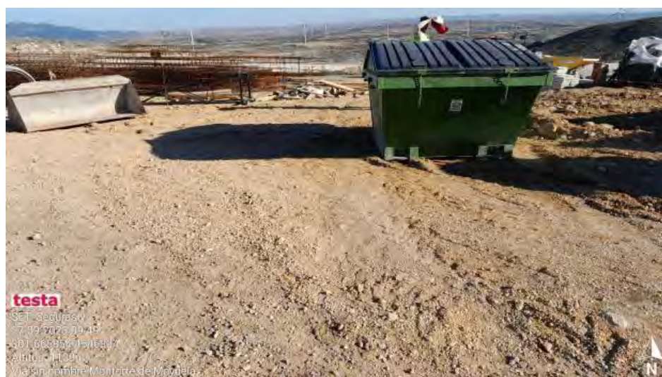
Limpieza de derrames en SET Seguras.
