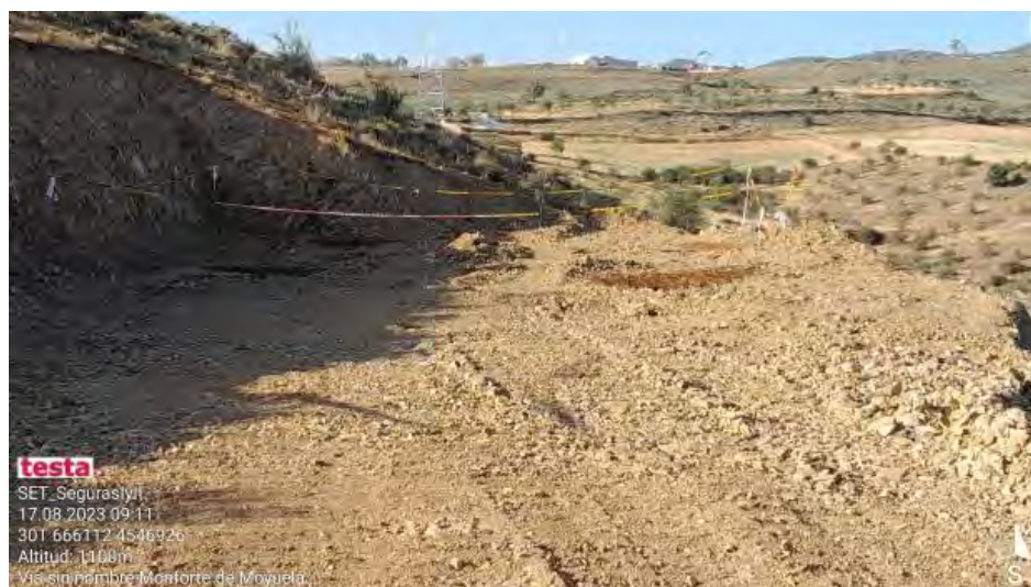
Preparación para hormigonado en AP-3 LAT Seguras
