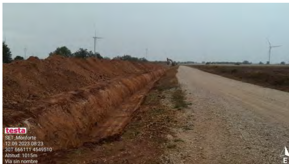
Zanja de evacuación en SET Monforte.
