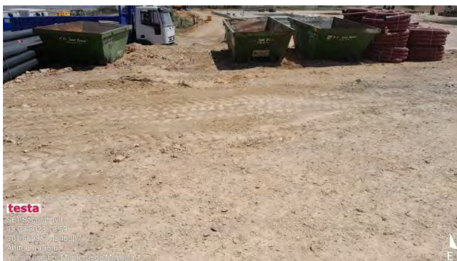
Limpieza de derrame en punto limpio.
