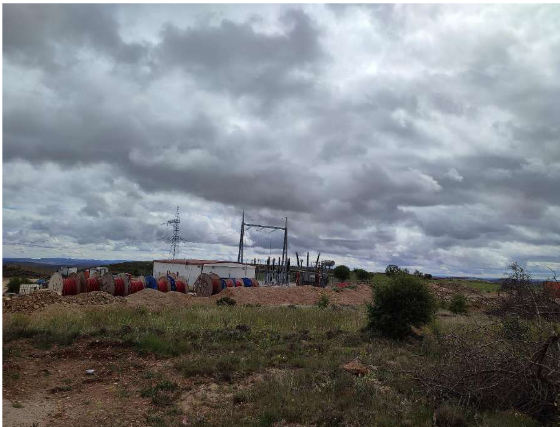
Set y punto limpio con bobinas. Tierra vegetal acopiada
