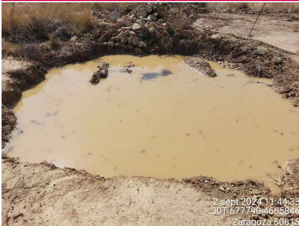
Imagen 1. Pozo de lavado de la SET inundado tras las lluvias caídas.
