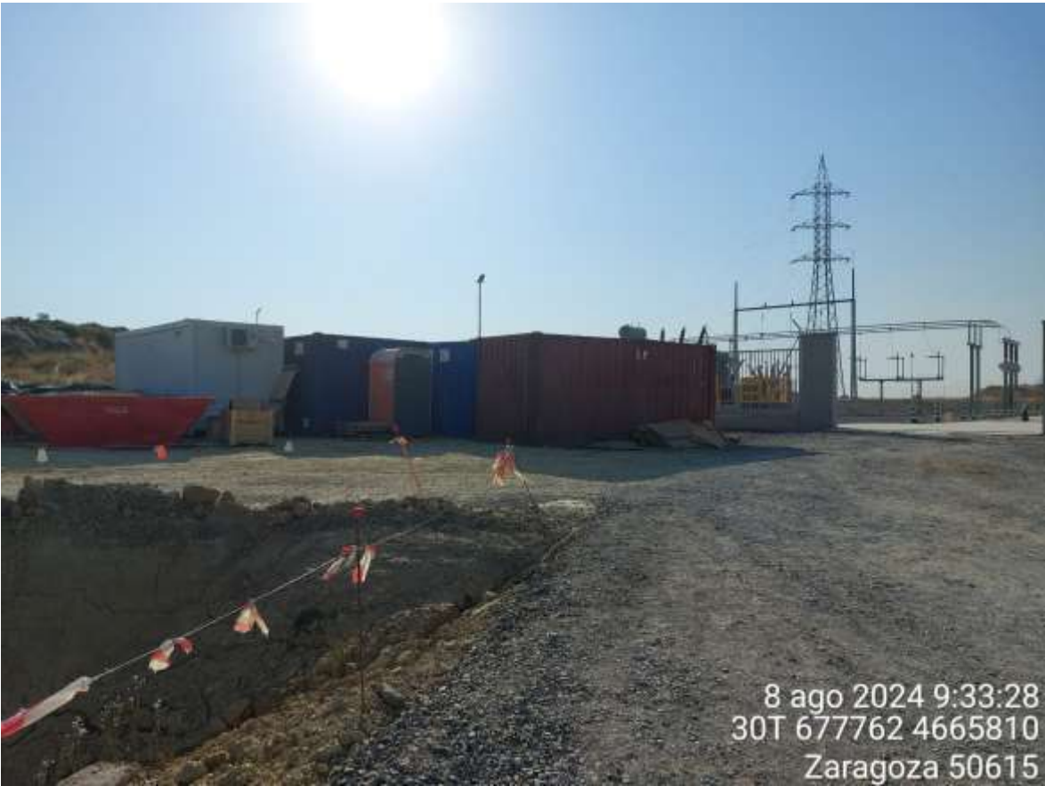
Imagen 1. Estado actual del entorno de la SET.
