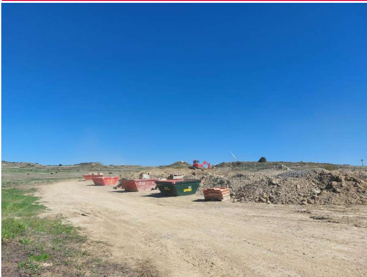
Imagen 1. Estado actual de la campa al lado de la SET.
