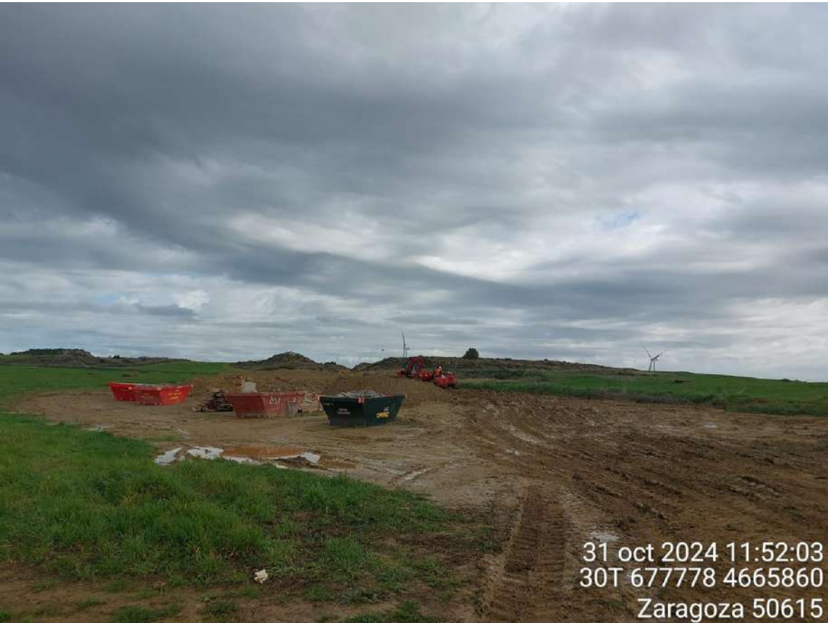
Imagen 1. Trabajos de movimiento de tierras en campa de SET San Licer.
