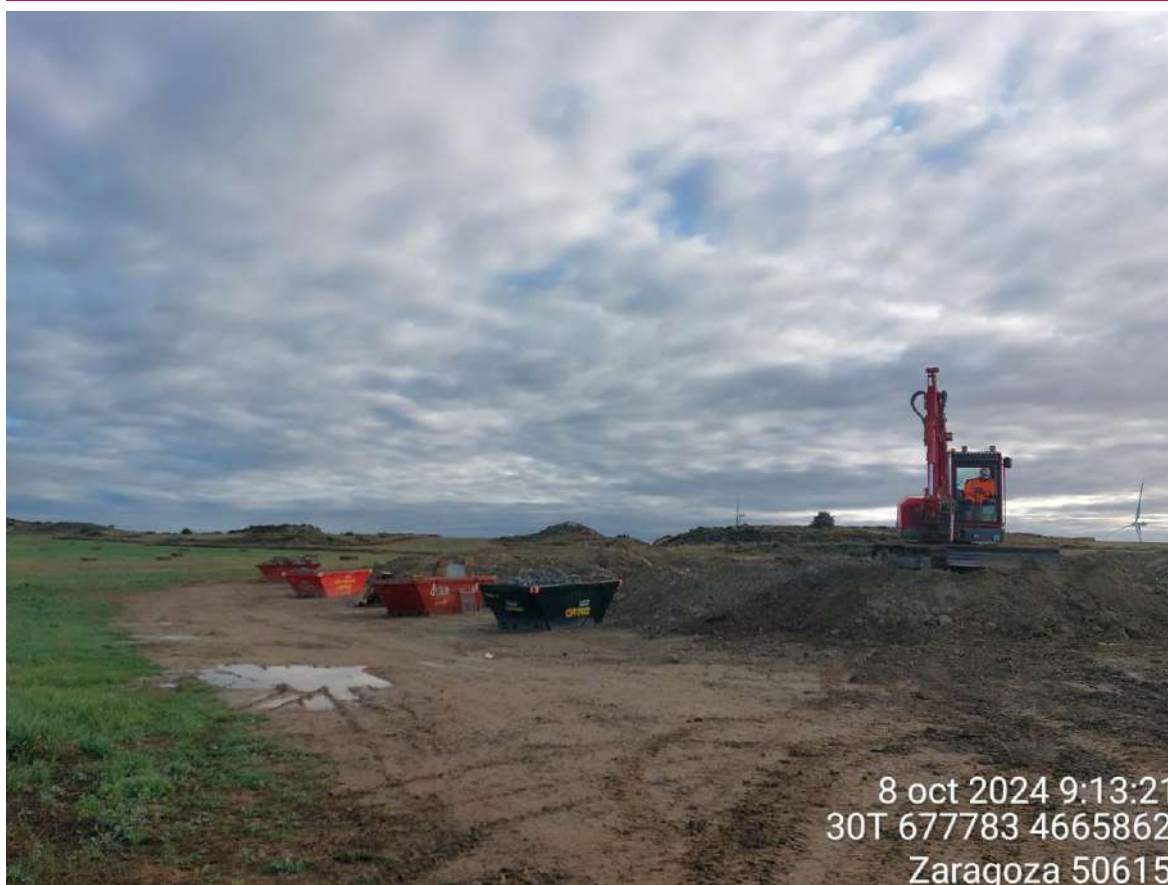
Imagen 1. Estado actual de la campa en SET San Licer 2.
