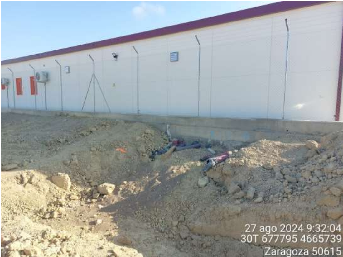
Imagen 1. Parte trasera de la SET tras realizar empalmes.
