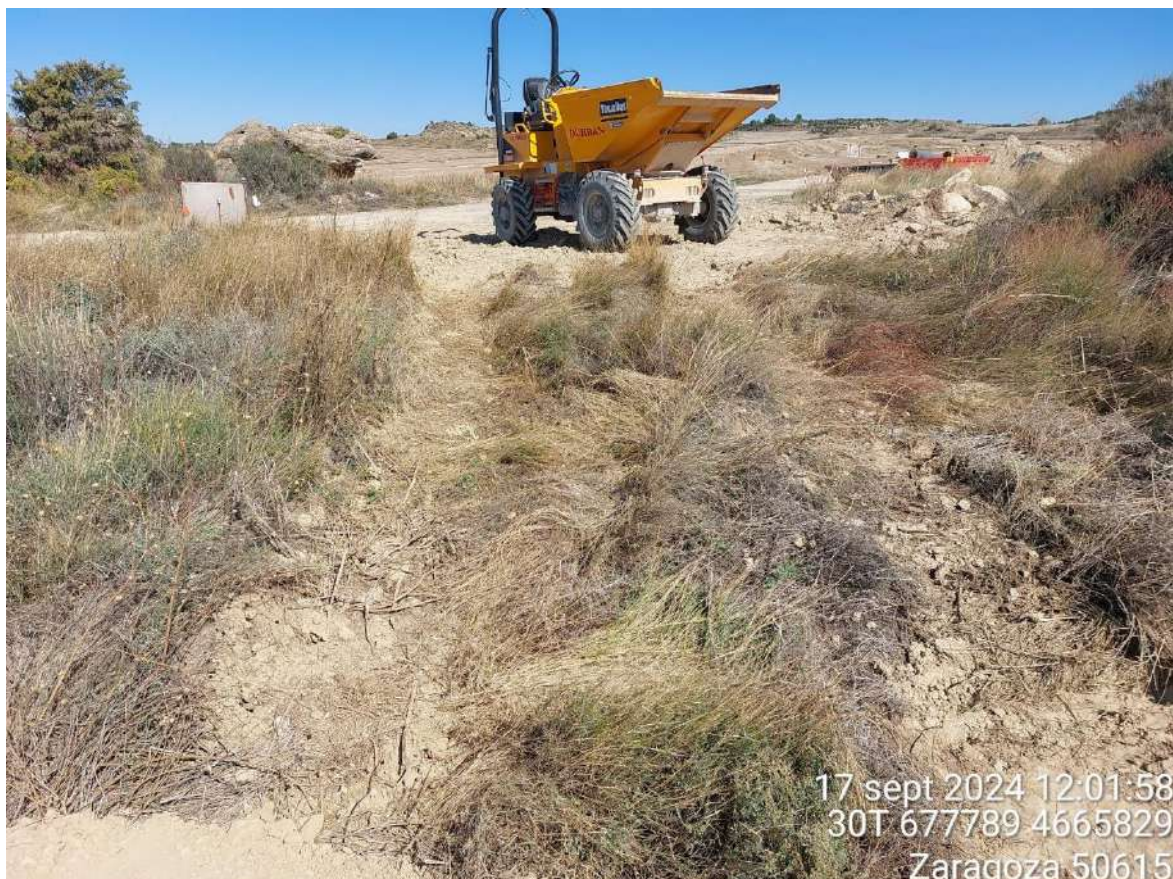
Imagen 2. No conformidad grave. Sobre afección en zona de vegetación natural por paso de maquinaria pesada.
