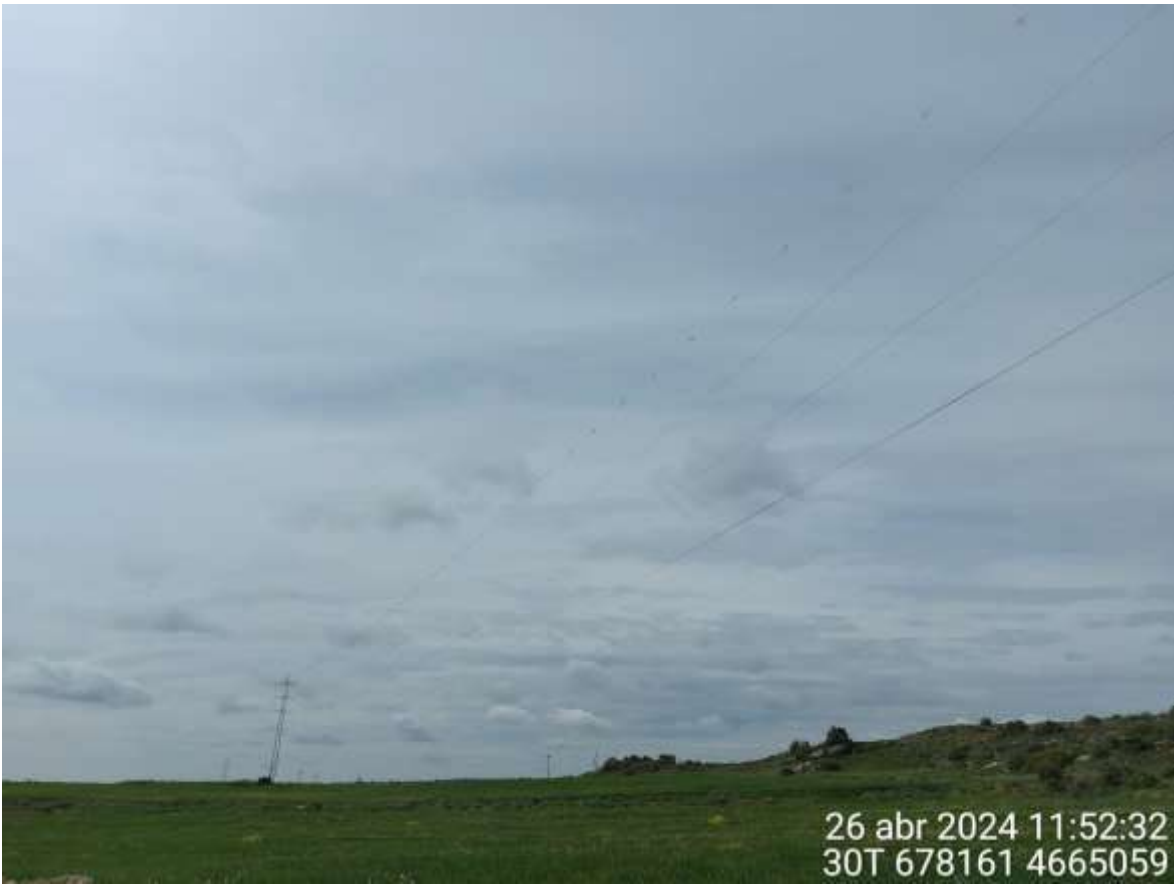
Imagen 1. Salvapájaros instalados en LAT San Licer.
