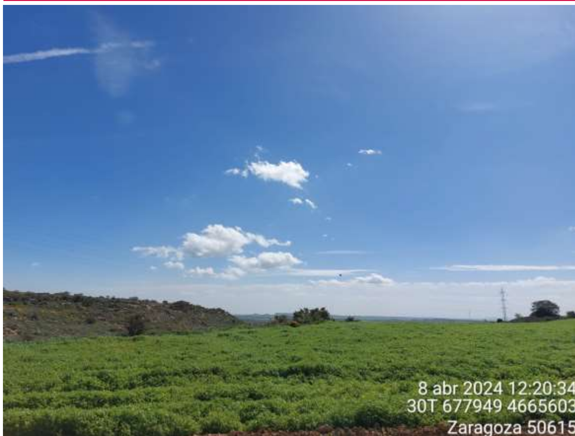
Imagen 1. Instalación de salvapájaros en LAT San Licer, apoyos 2-3.
