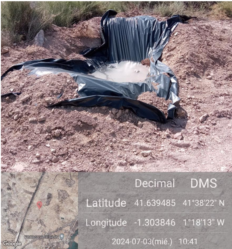
Ilustración 14. Limpieza de cubas de hormigón en uno de los apoyos aislado con plástico.
