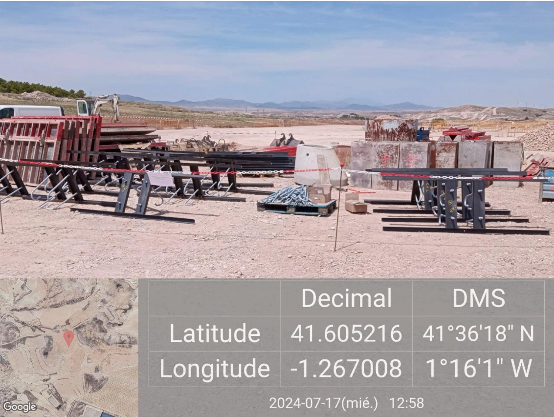
Ilustración 16. Acopio de materias en la SET Este.
