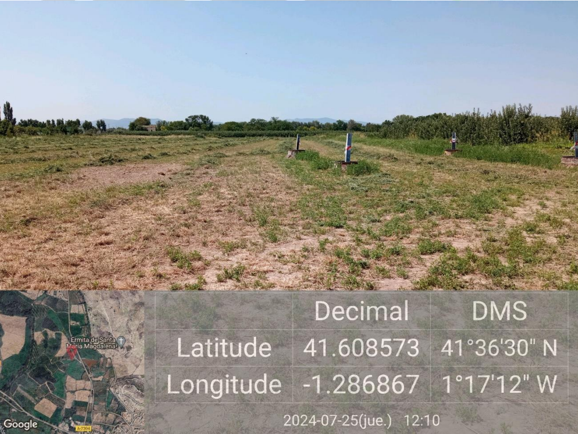
Ilustración 17. Apoyo hormigonado y con sobrantes de excavación gestionados.
