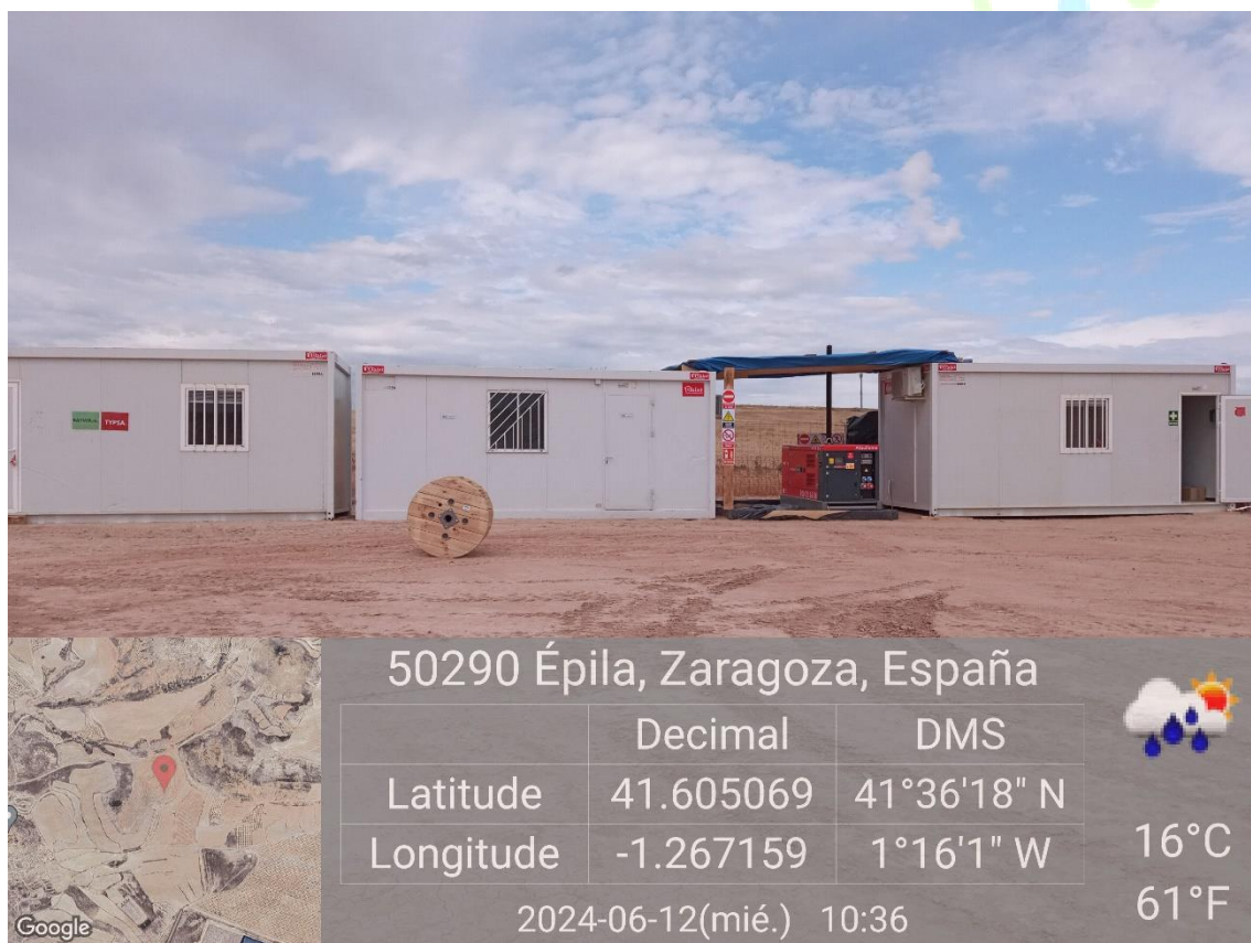
Ilustración 10. Casetas de la SET Este.
