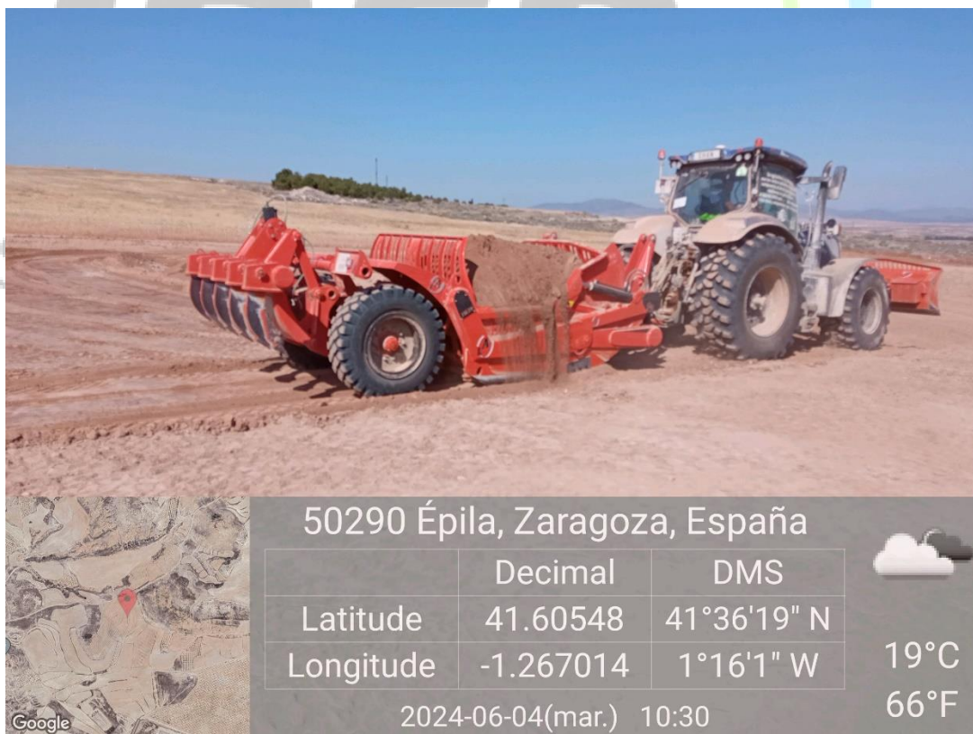
Ilustración 8. Retirada de tierra vegetal en la SET Este.
