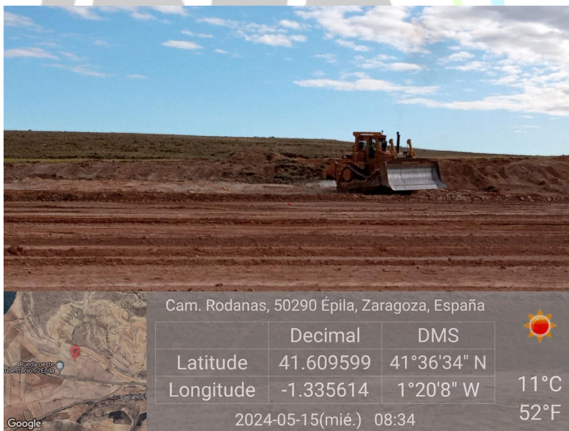
Ilustración 2. Movimientos de tierra en la SET Oeste.
