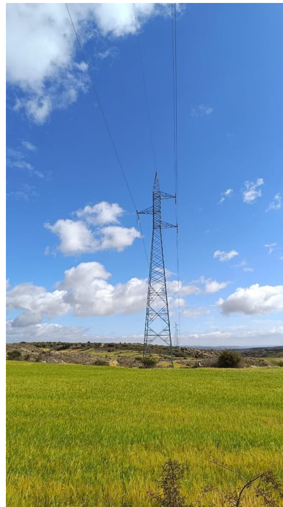
Fotografías 5 a 8: Apoyos de celosía y tendido con salvapájaros
