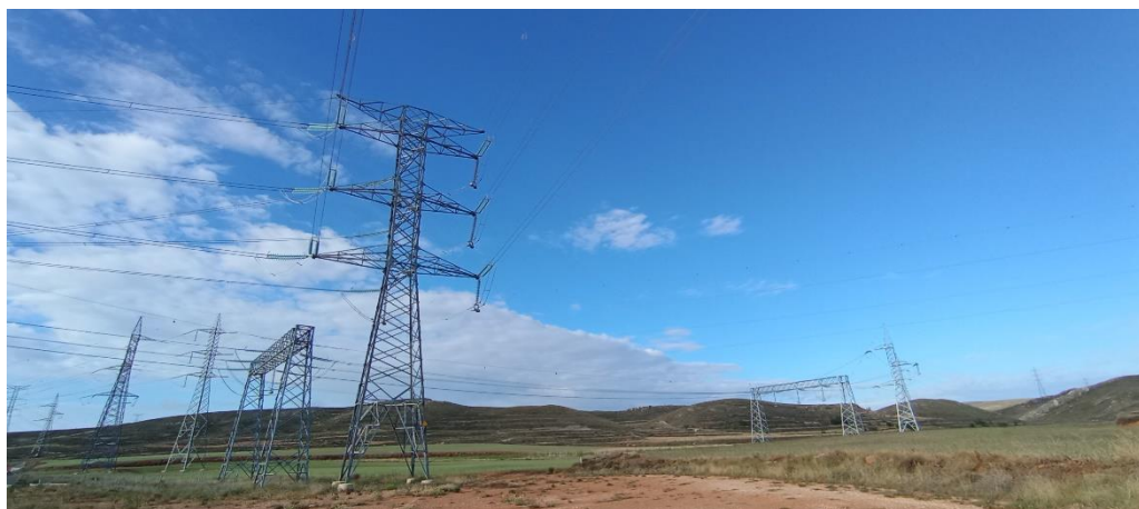
Fotografías 1 a 2: Visibilidad línea eléctrica
