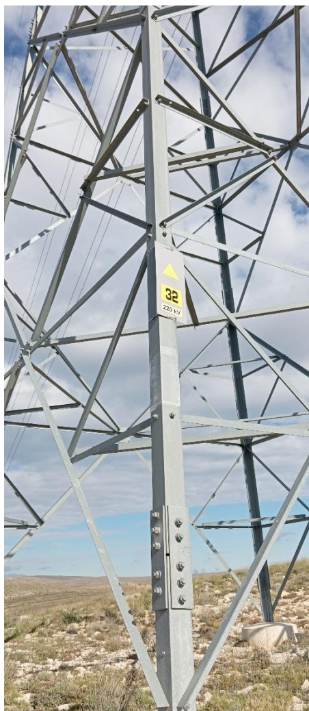
Fotografía 9: Señalización en apoyo
