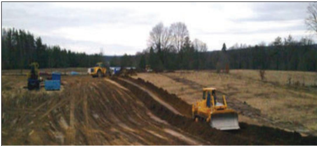
Figura 15. Ejemplo de nivelación de terreno
