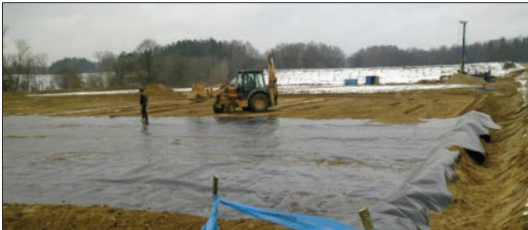
Figura 16. Ejemplo de impermeabilización del emplazamiento
