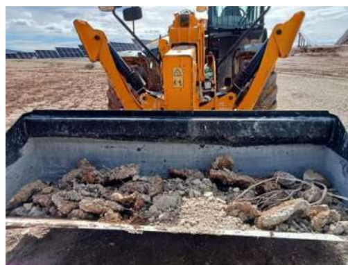
Figura 23 Retirada del vertido de hormigón
