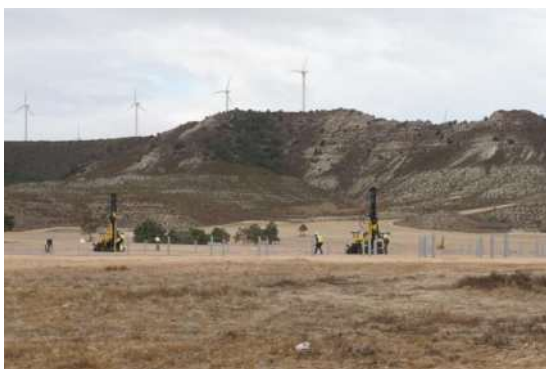
Figura 6 Hincado de estructuras
