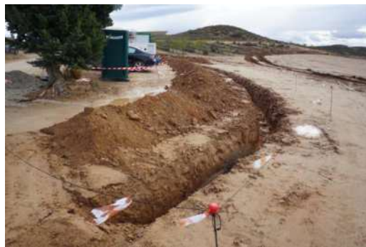
Figura 3 Apertura de zanja evacuación eléctrica
