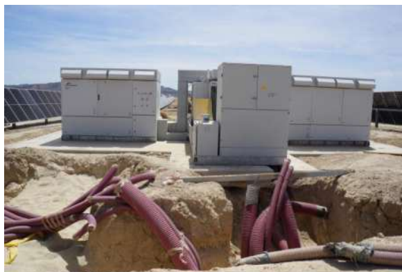
Figura 11 Conexión de centro de transformación
