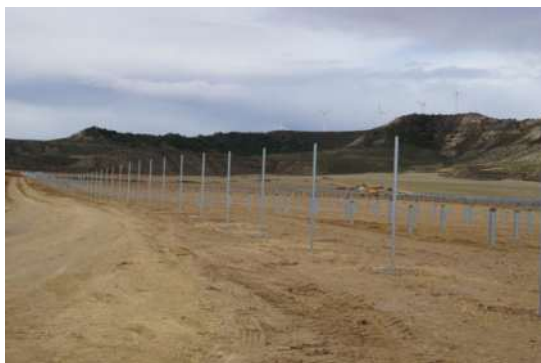
Figura 4 Postes del vallado y trackers instalados
