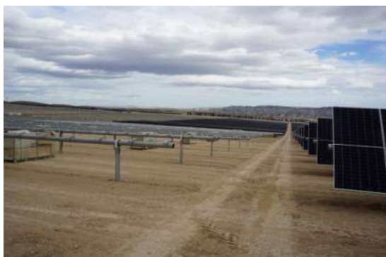
Figura 8 Montaje de los módulos fotovoltaicos
