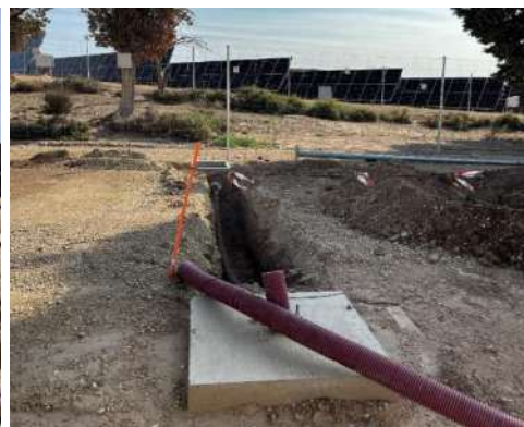
Figura 12 Instalación de la red del CCTV
