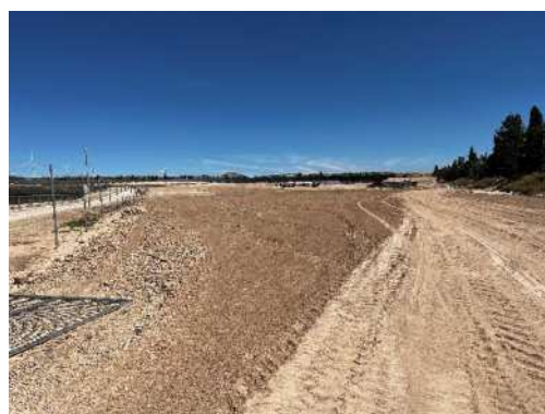
Figura 30 Extendido de tierra vegetal en la zona afectada
