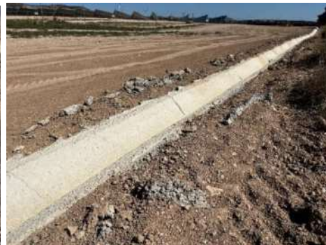
Figura 16 Cimentación de las cunetas
