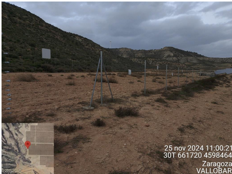
Fotografía 6. Vista al vallado perimetral de la PSFV
