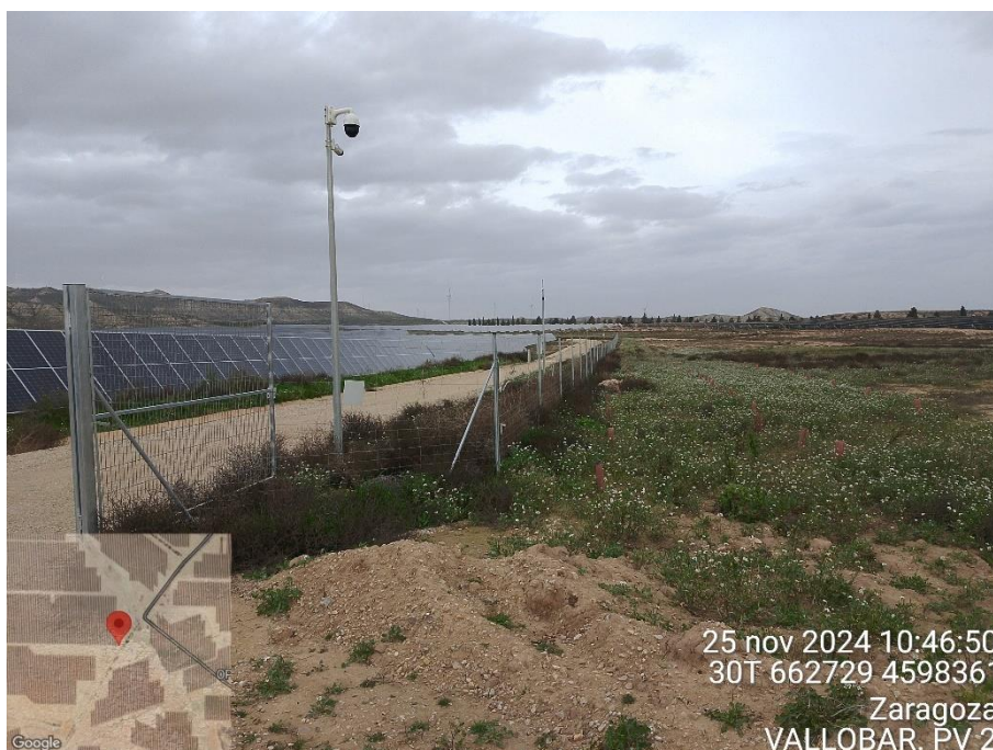
Fotografía 2. Pantalla vegetal junto al vallado perimetral de PSFV Vallobar Zona 01
