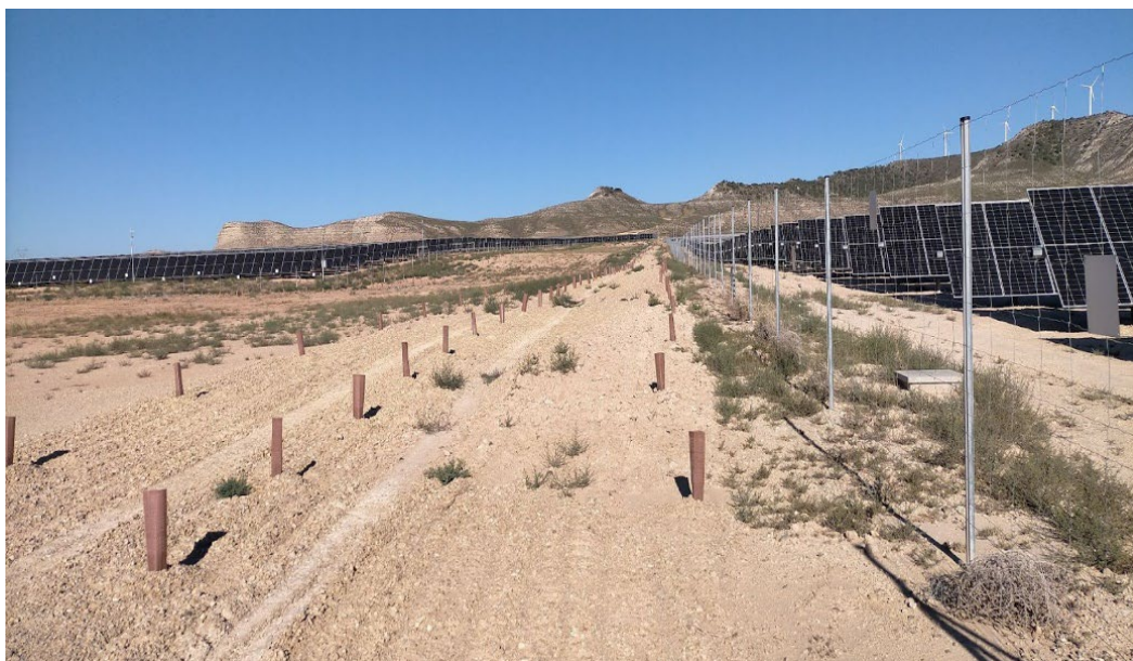
Fotografía 2. Pantalla vegetal próxima al vallado perimetral de PSFV Vallobar Zona 01
