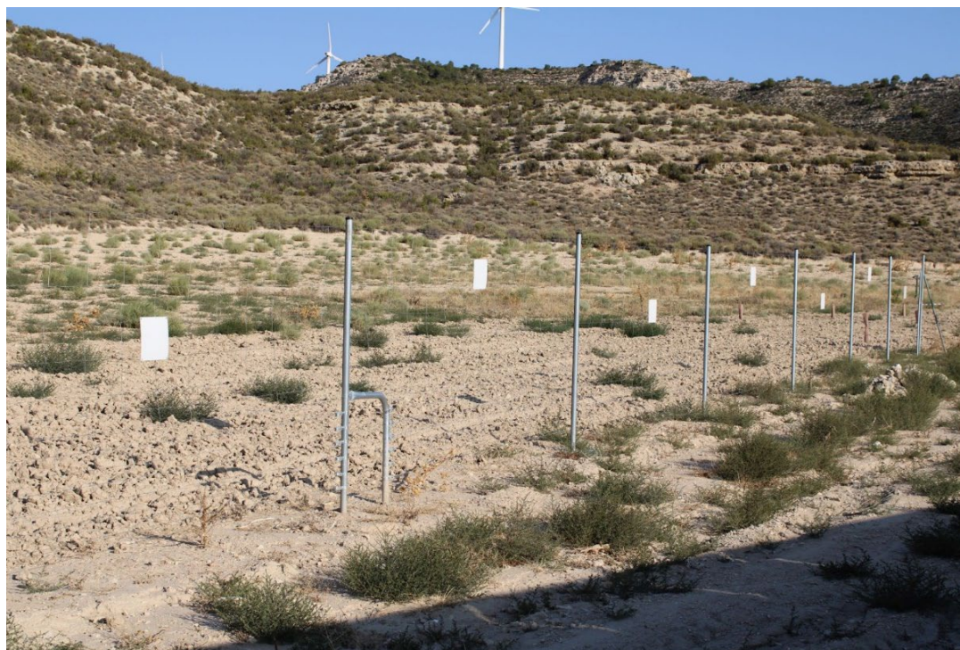
Fotografía 5. Vallado perimetral y paso de fauna en PSFV Vallobar
