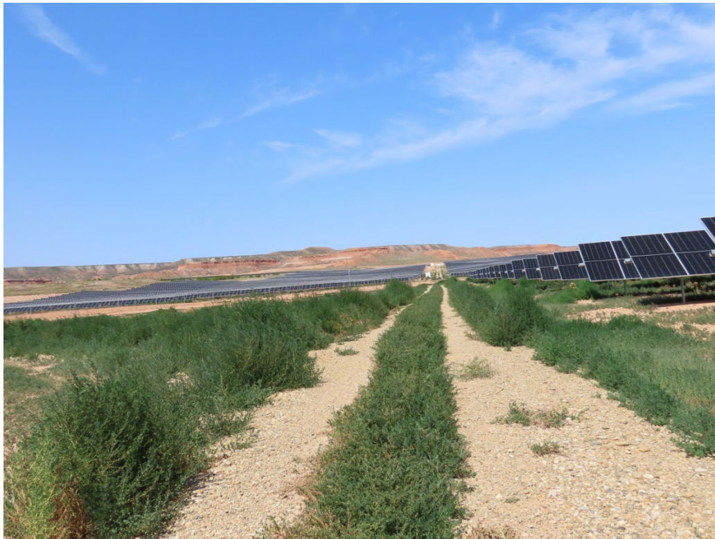
Figura 7. Presencia de vegetación en vial interior (Valdompere 4)
