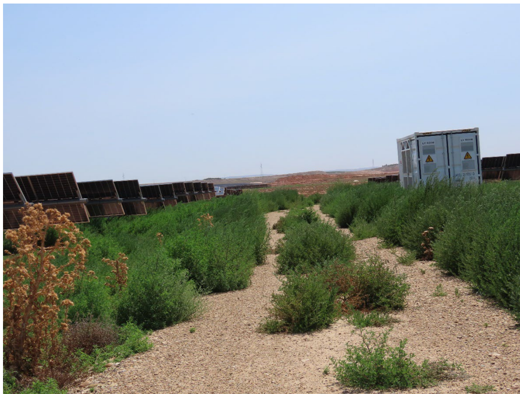
Figura 3. Presencia de vegetación en vial interior (Valdompere 4)
