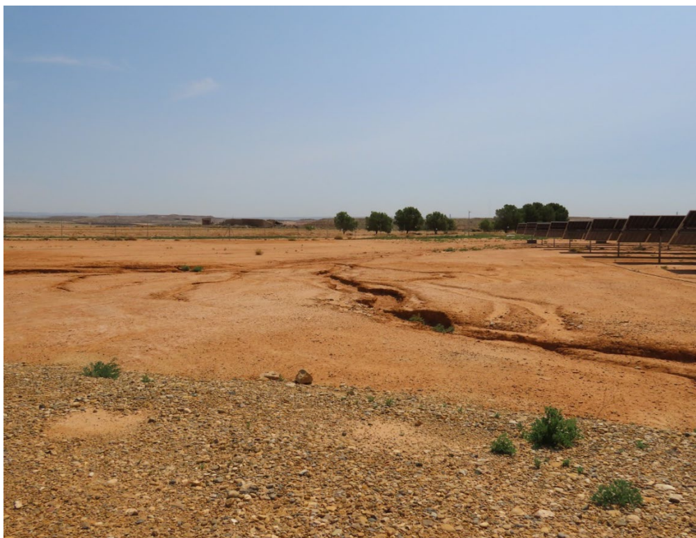
Figura 8. Zona con procesos erosivos
