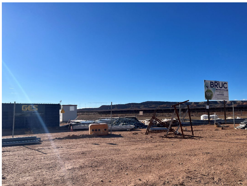
Figura 8 Acopio del material de construcción
