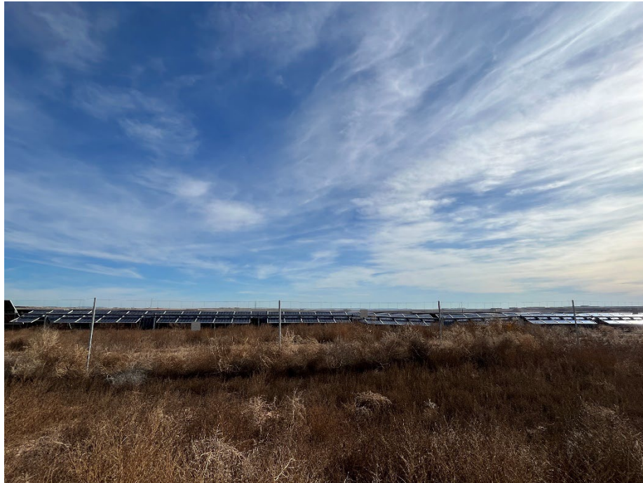
Figura 9 Acumulación de capitanas en el vallado perimetral
