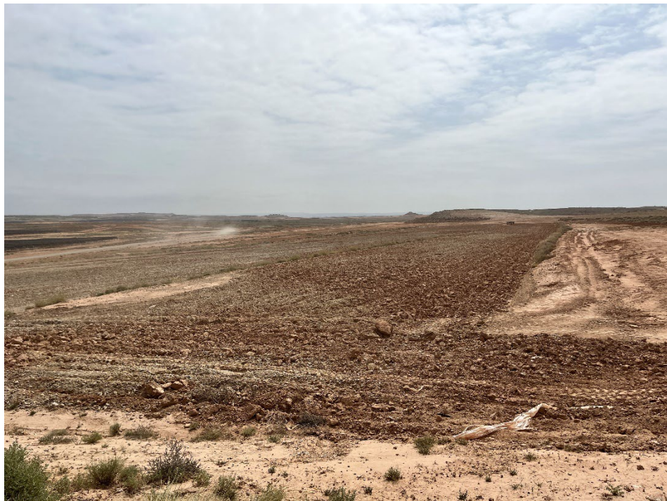
Figura 8 Rehabilitación de la zona de acopios
