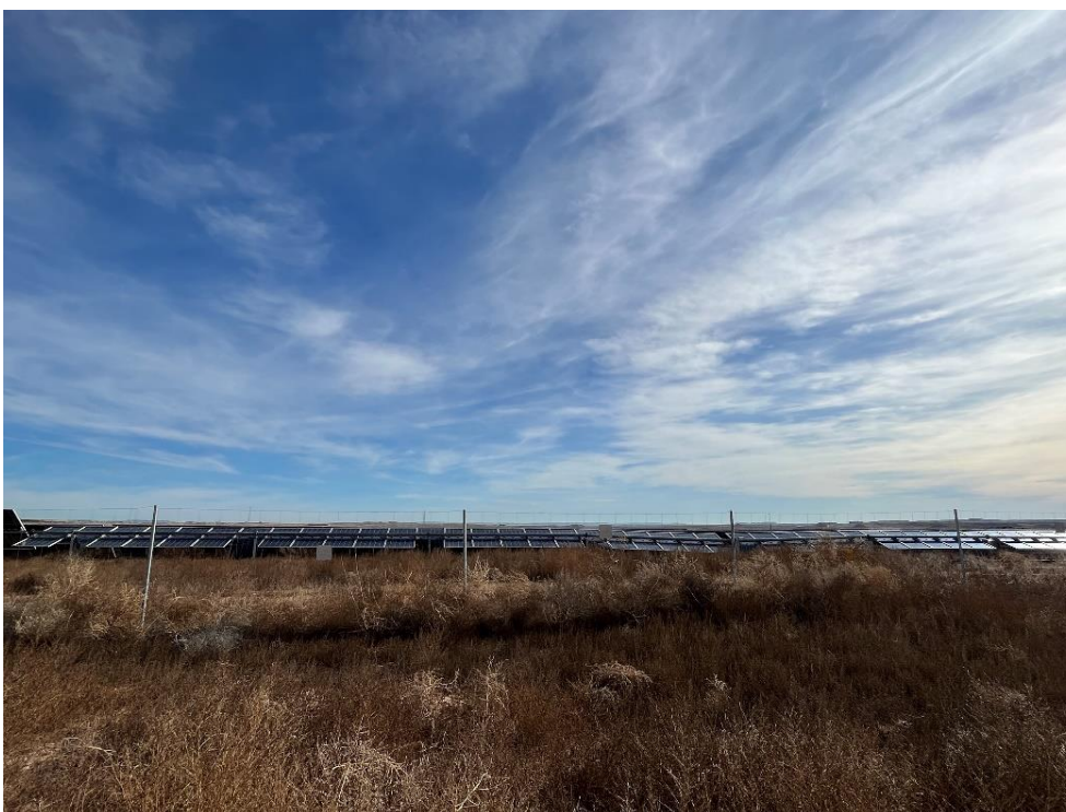
Fotografía 6: Acumulación de capitanas en el vallado perimetral
