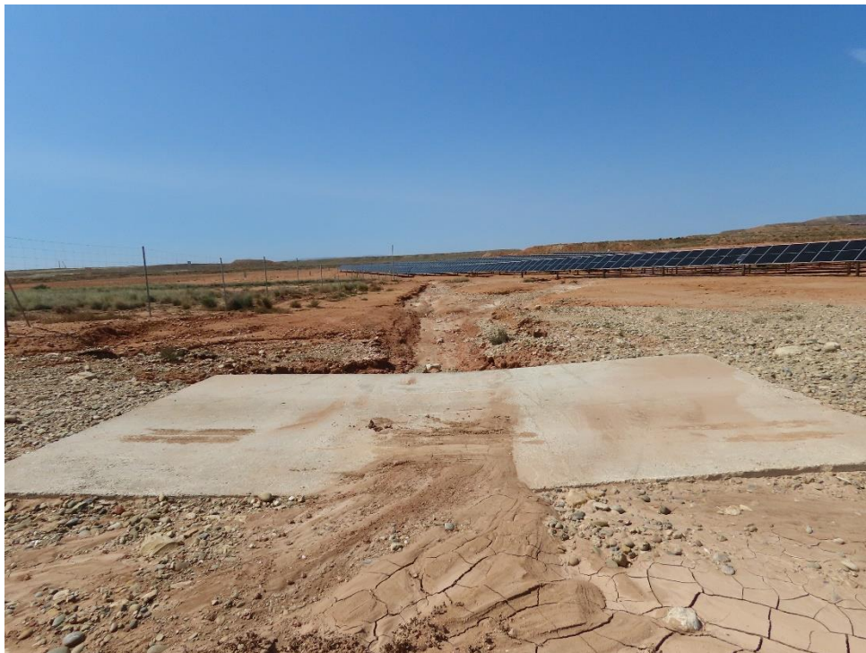
Figura 1. Formación de barranco y arrastre de gravas en paso de hormigón (Valdompere 3)
