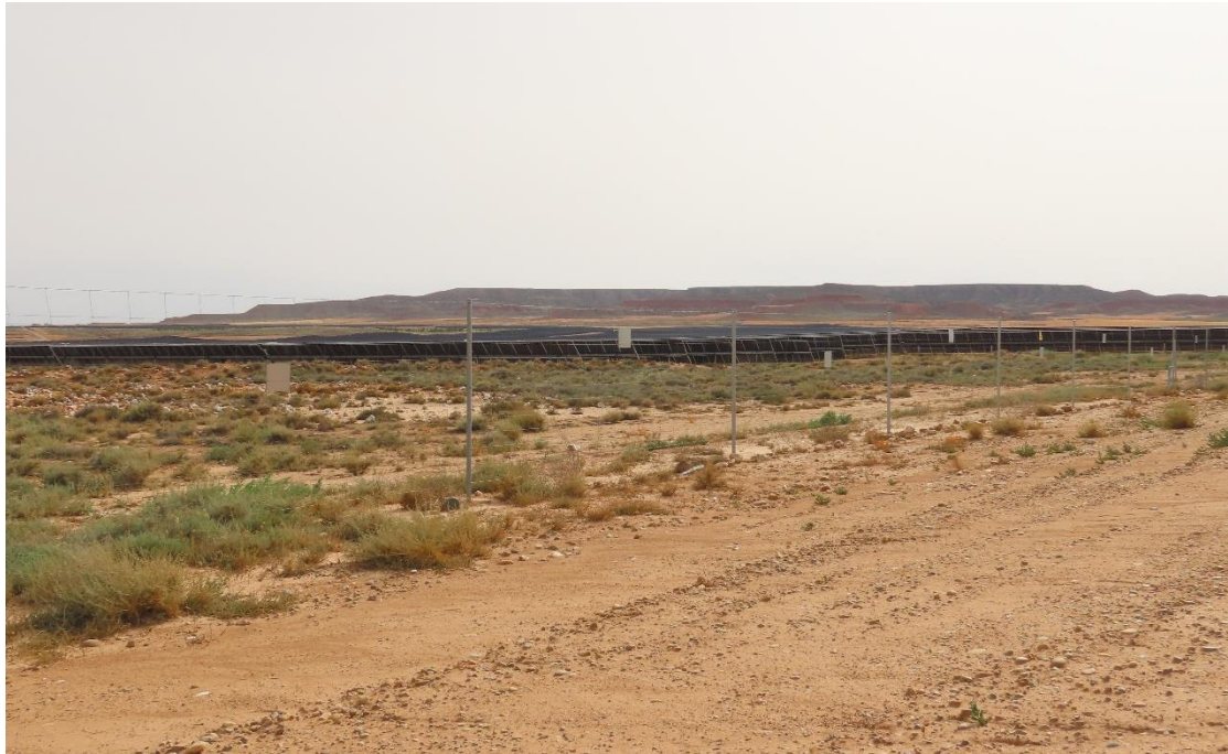
Fotografía 3: Presencia de capitanas en el vallado perimetral
