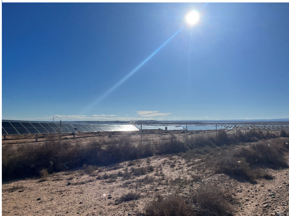
Figura 8 Acumulación de capitans en el vallado perimetral
