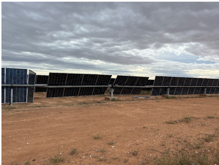
Figura 9 Trackers partidos y módulos rotos
