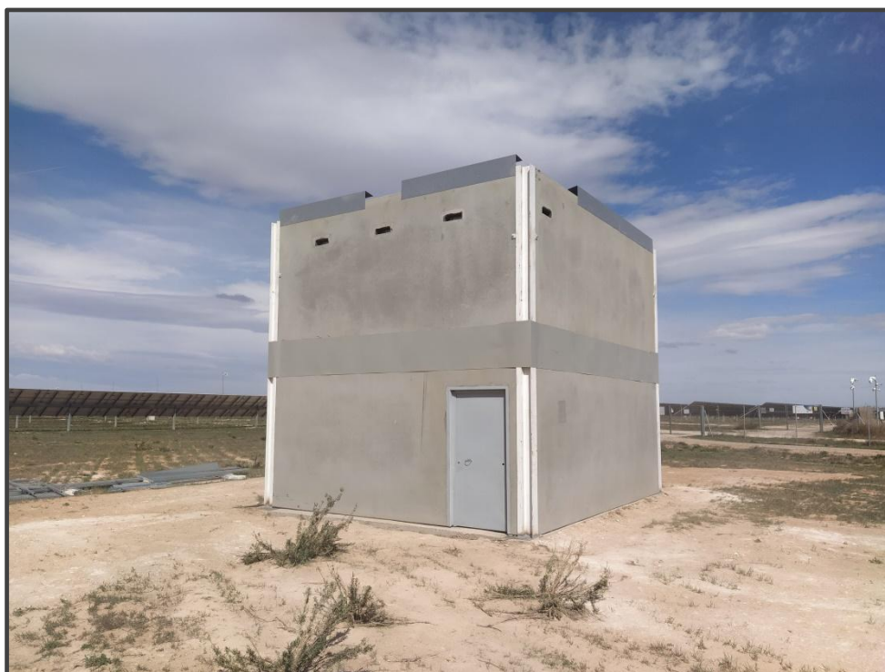
Fotografía 19. Exterior del primillar de nueva construcción.
