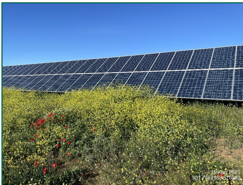
Fotografía 1. Vegetación entre placas actualmente.
