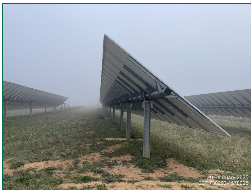
Fotografía 1. Vegetación entre placas actualmente.
