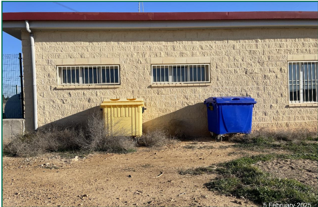
Fotografía 52. Contenedores de residuos no peligrosos en exterior de la subestación.
