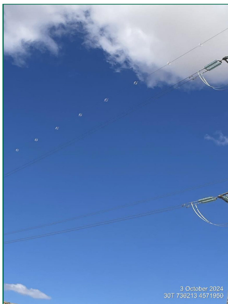
Fotografía 10. Línea eléctrica con balizas salvapájaros
