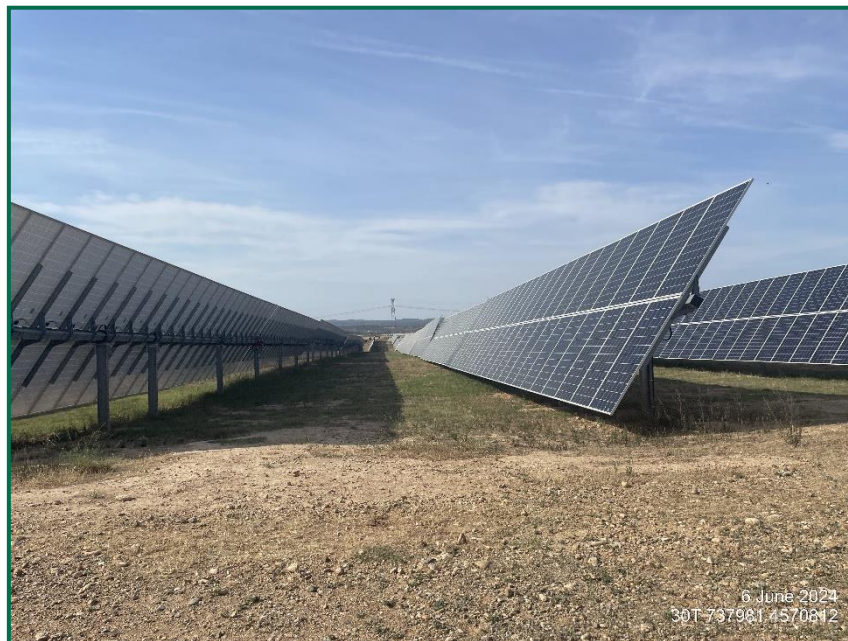
Fotografía 1. Vegetación entre placas actualmente.
