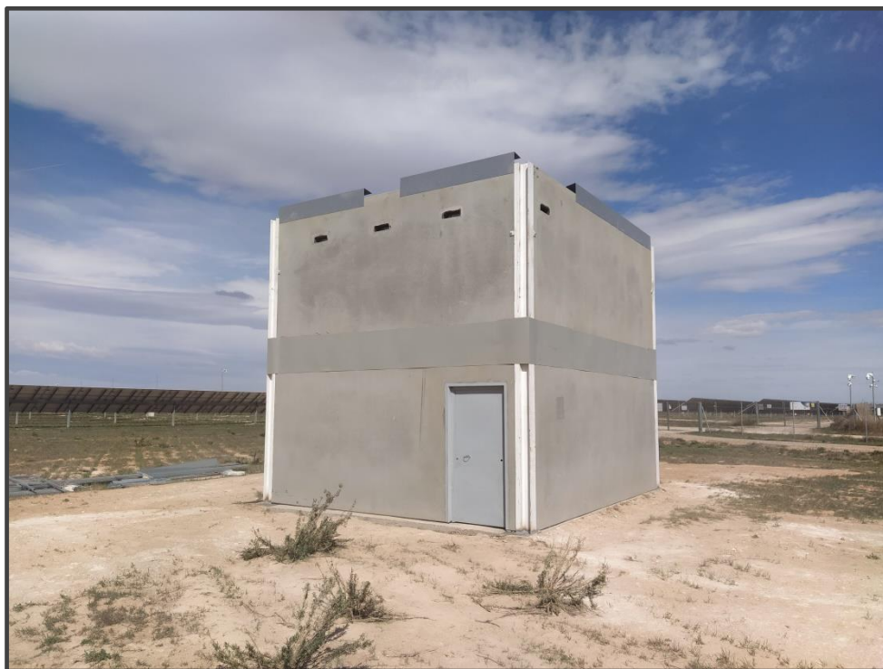
Fotografía 21. Exterior del primillar de nueva construcción.
