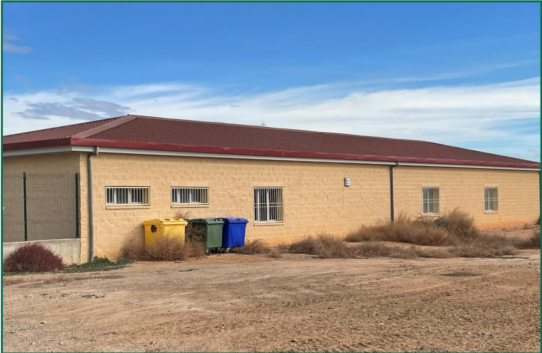
Fotografía 44. Contenedores de residuos no peligrosos en exterior de la subestación.
