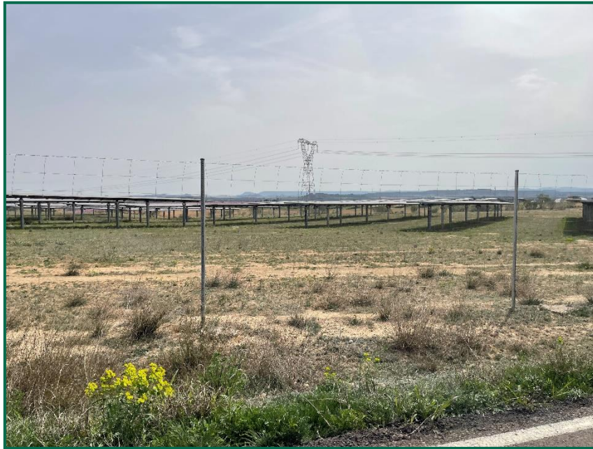
Fotografía 2. Vegetación entre placas actualmente.
