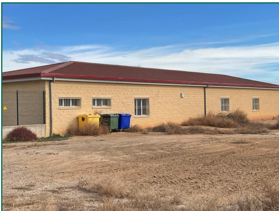
Fotografía 23. Contenedores de residuos no peligrosos en exterior de la subestación.
