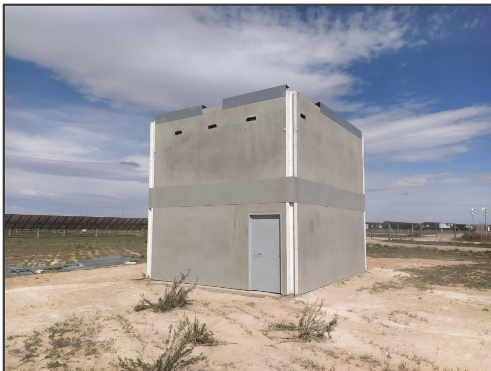
Fotografía 14. Exterior del primillar de nueva construcción.
