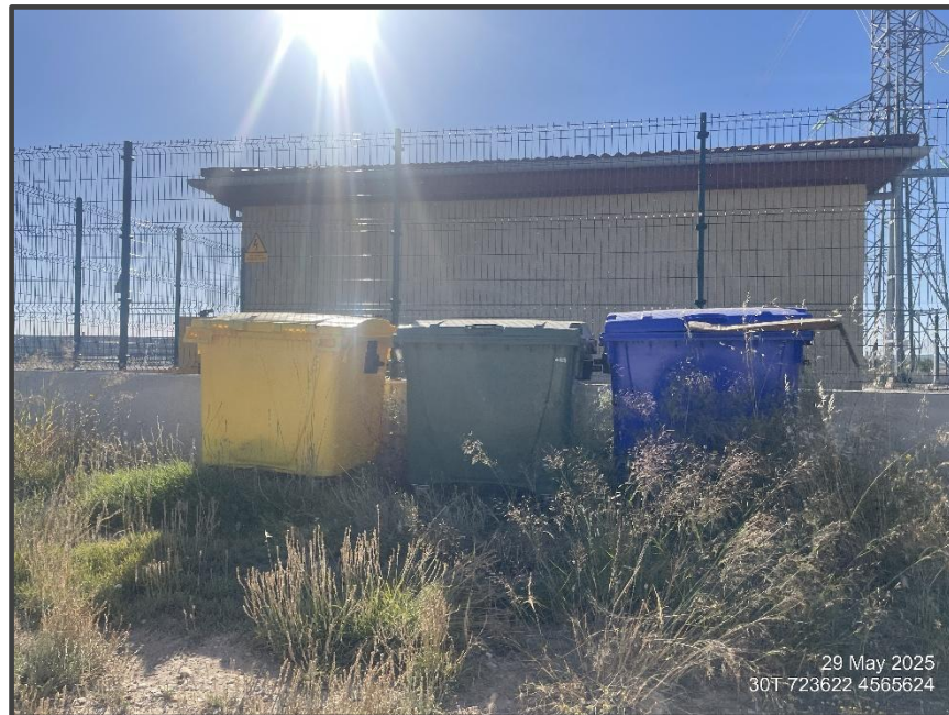
Fotografía 22. Zona de contenedores.
