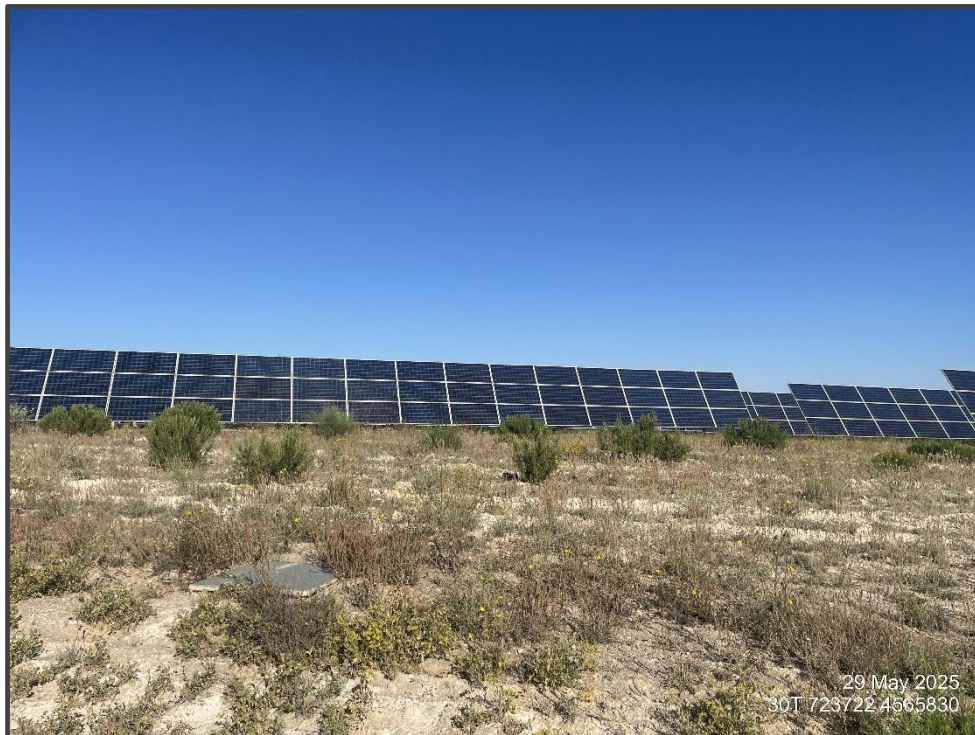
Fotografía 23. Zonas con revegetación.
