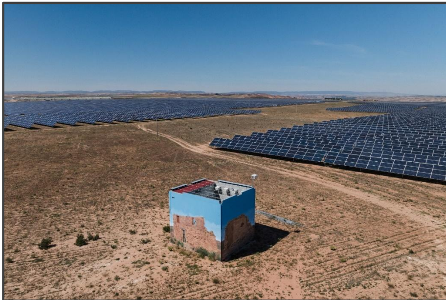
Fotografía 9. Exterior del primillar, pintado.
