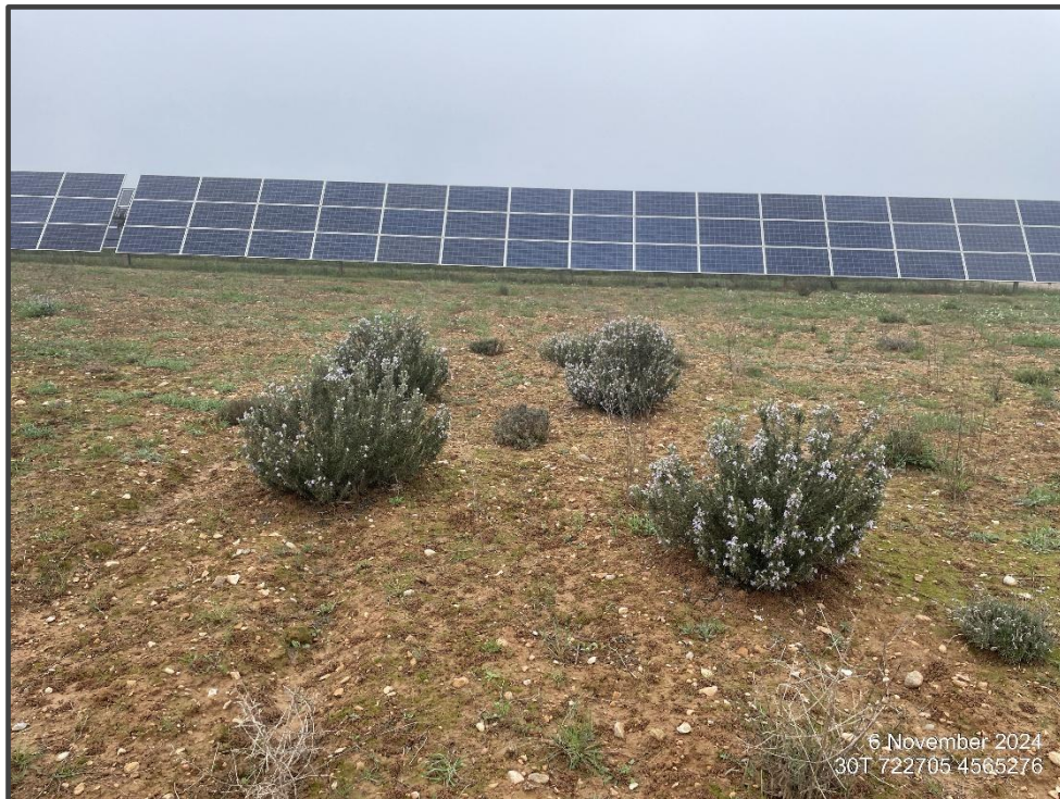
Fotografía 29. Zonas con revegetación.
