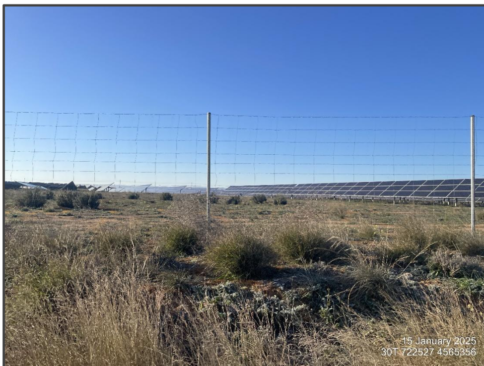
Fotografía 30. Zonas con revegetación.
