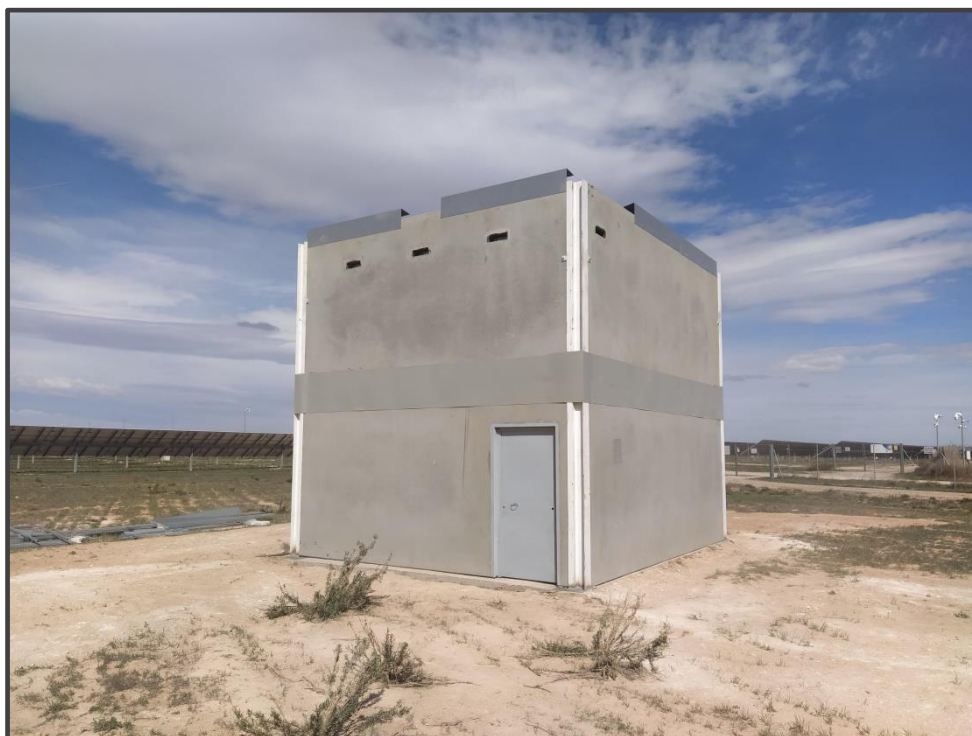
Fotografía 6. Exterior del primillar de nueva construcción.
