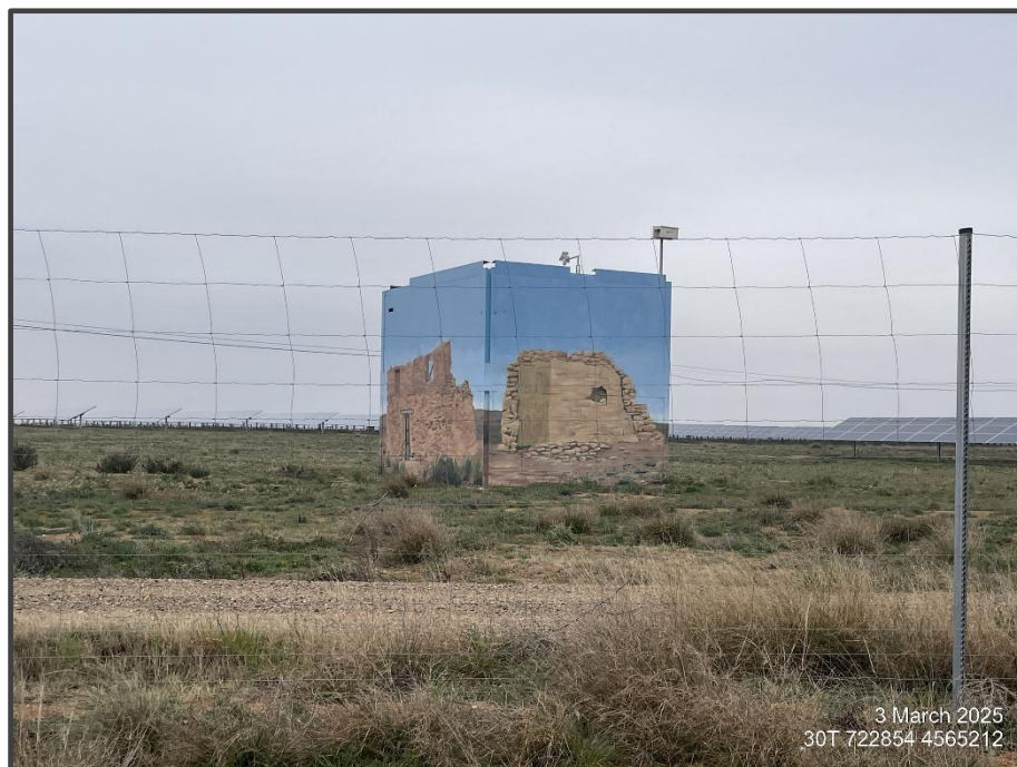
Fotografía 20. Exterior del primillar, pintado.
