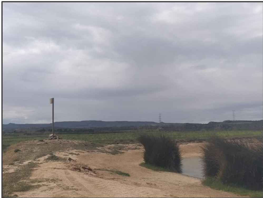
Fotografía 42. Caja para carraca, sobre poste.
