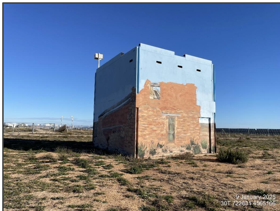
Fotografía 27. Exterior del primillar, pintado.
