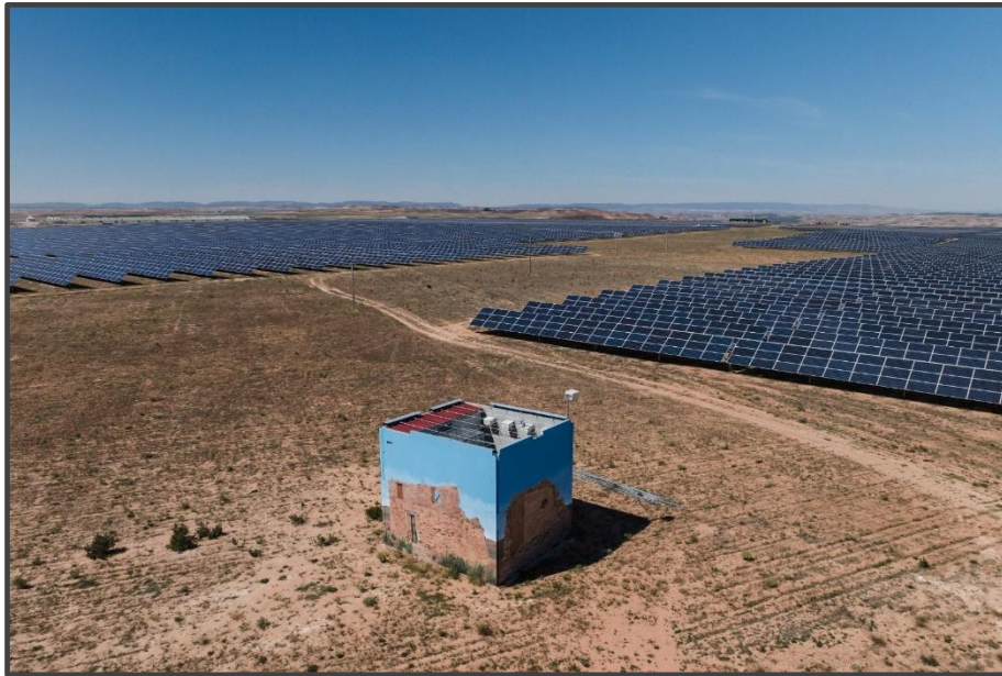
Fotografía 28. Exterior del primillar, pintado.
