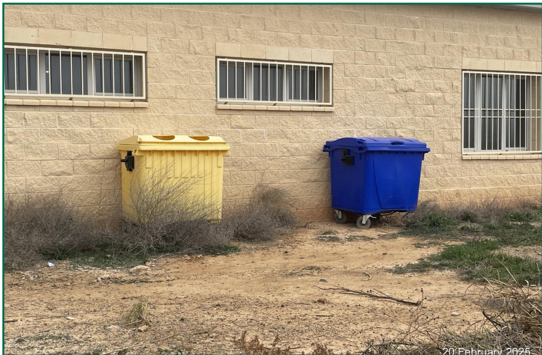
Fotografía 47. Contenedores de residuos no peligrosos en exterior de la subestación.
