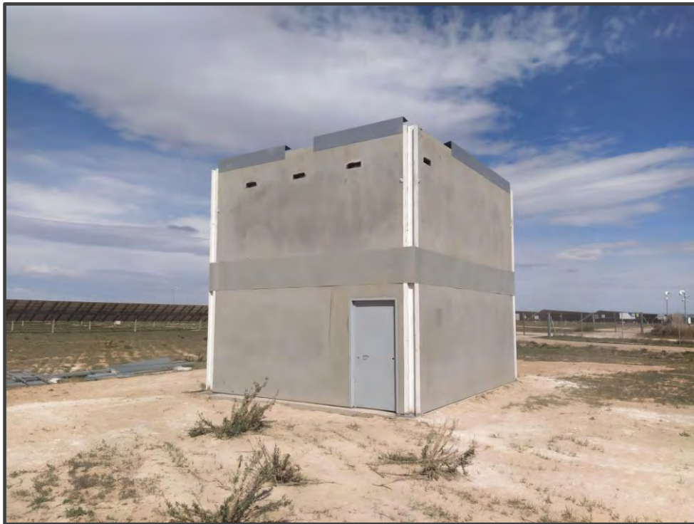
Fotografía 15. Exterior del primillar de nueva construcción.
