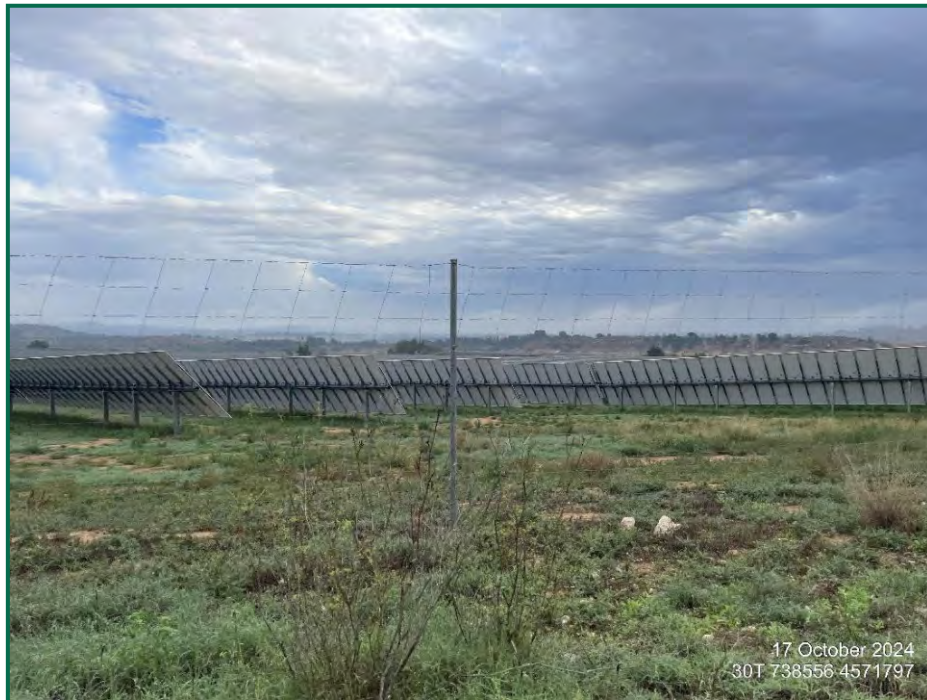
Fotografía 2. Vegetación entre placas actualmente.
