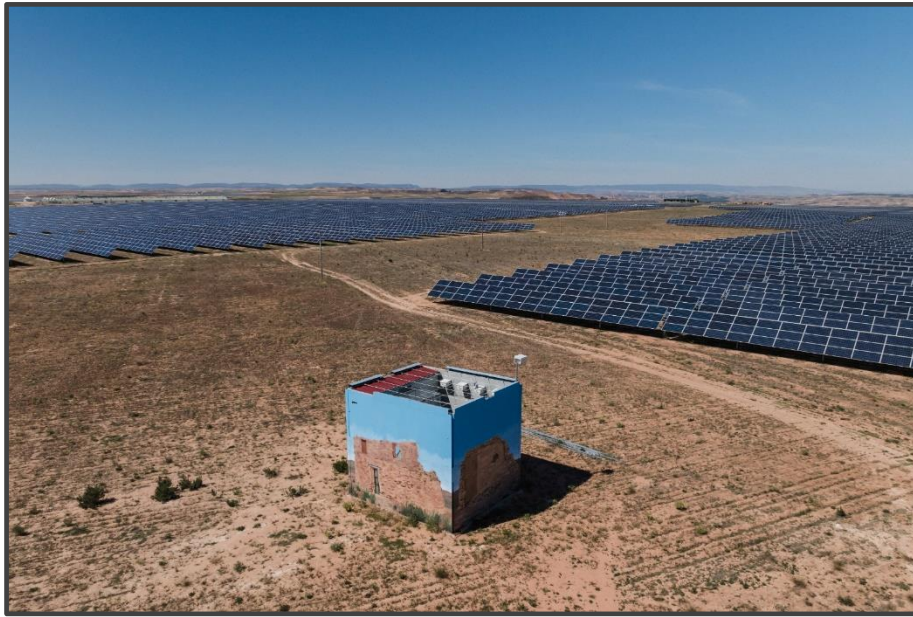
Fotografía 18. Exterior del primillar, pintado.
