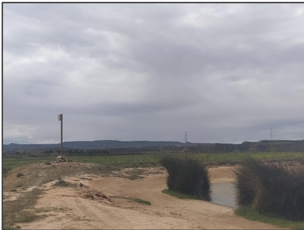
Fotografía 31. Caja para carraca, sobre poste.
