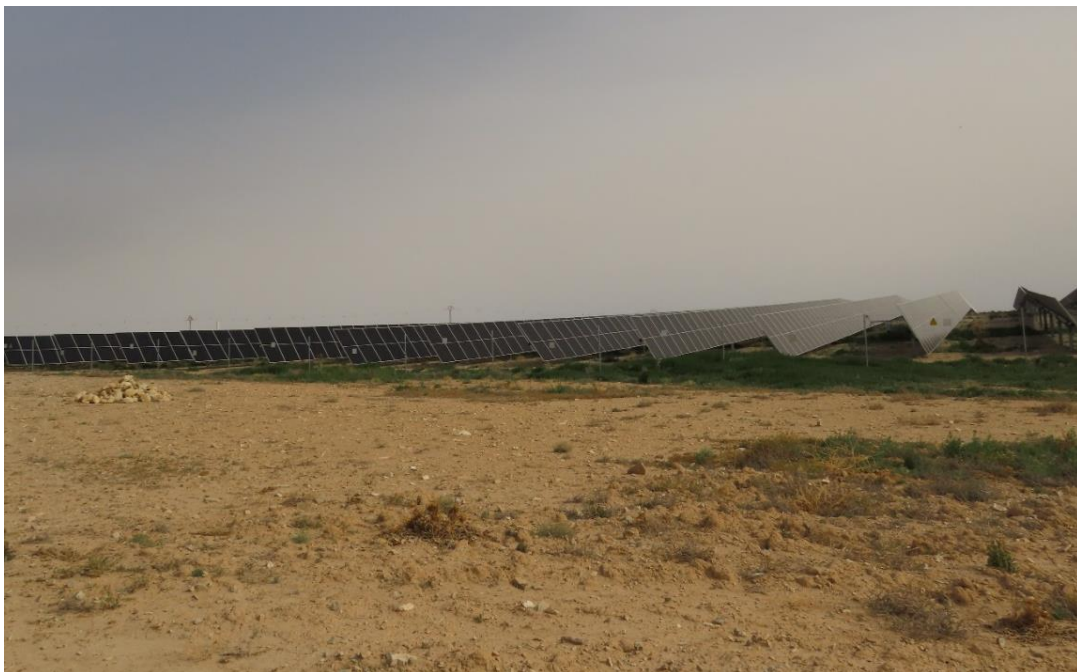
Fotografía 10: Vegetación bajo paneles en el último trimestre del ciclo anual
