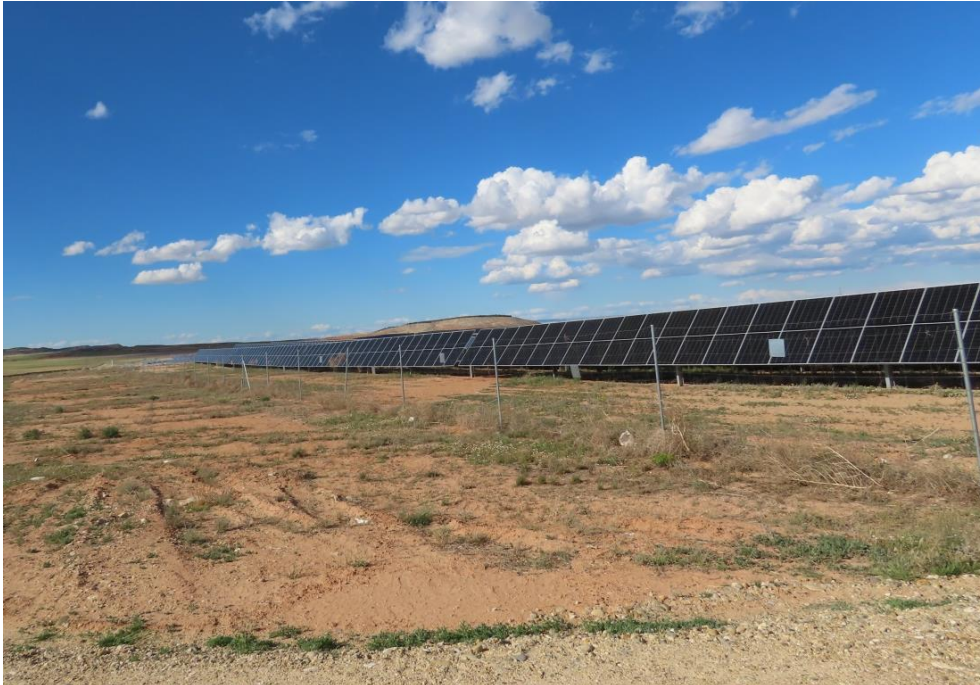
Fotografía 1: Estado general de limpieza vallado perimetral.
