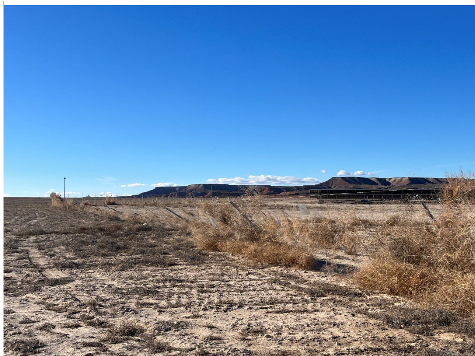
Figura 8 Vallado perimetral vencido por la acumulación de capitanas
