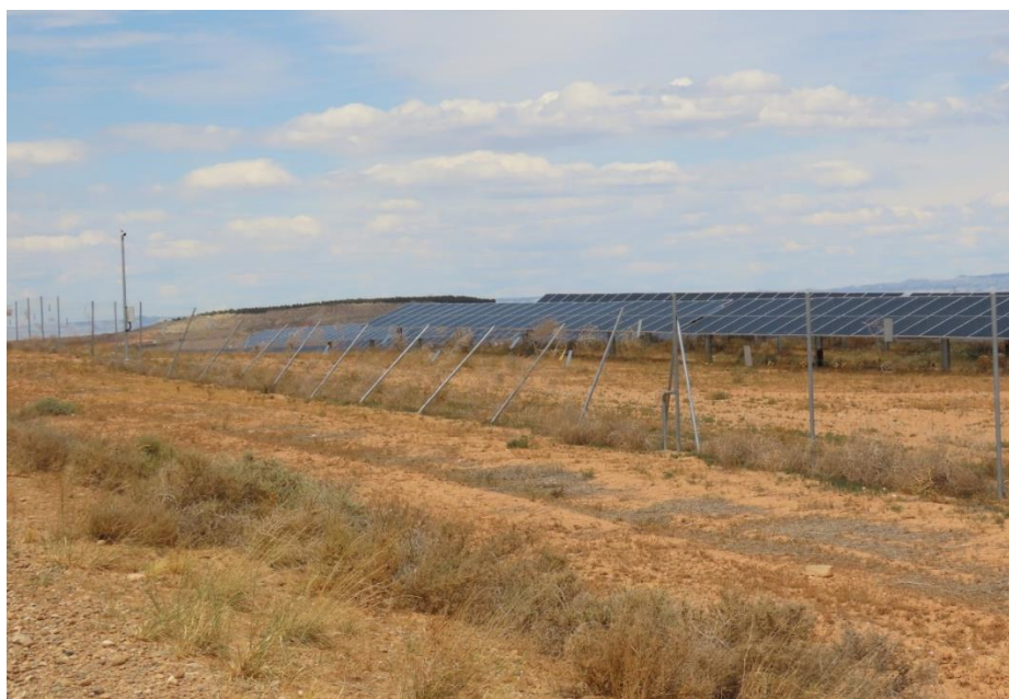
Fotografía 3: Zona oeste del vallado perimetral
