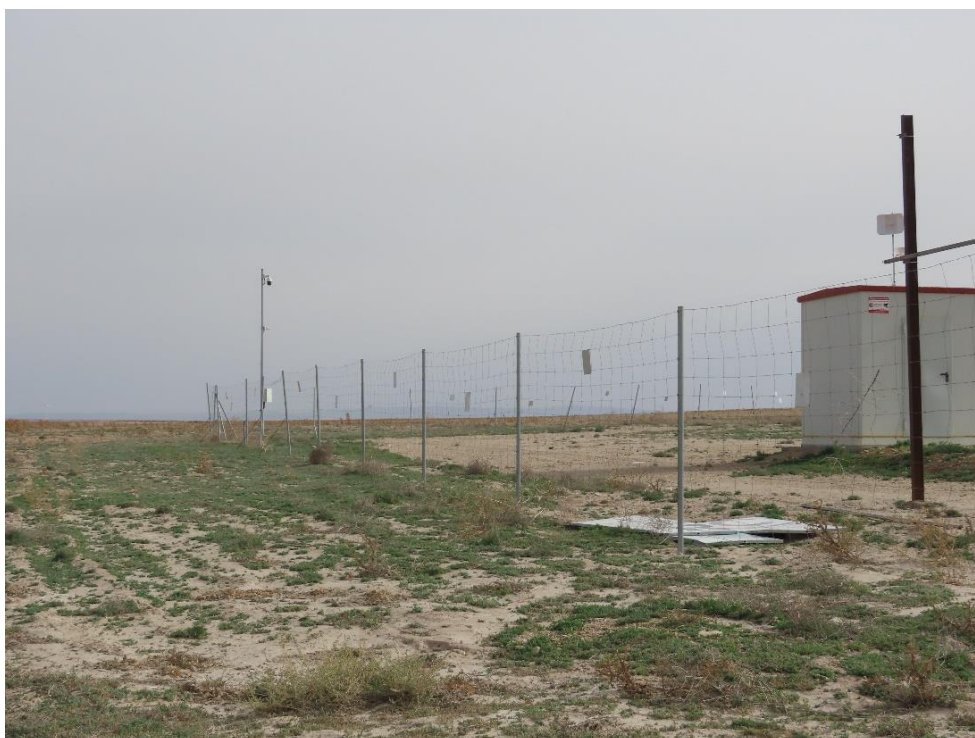
Fotografía 2: Entorno del vallado perimetral
