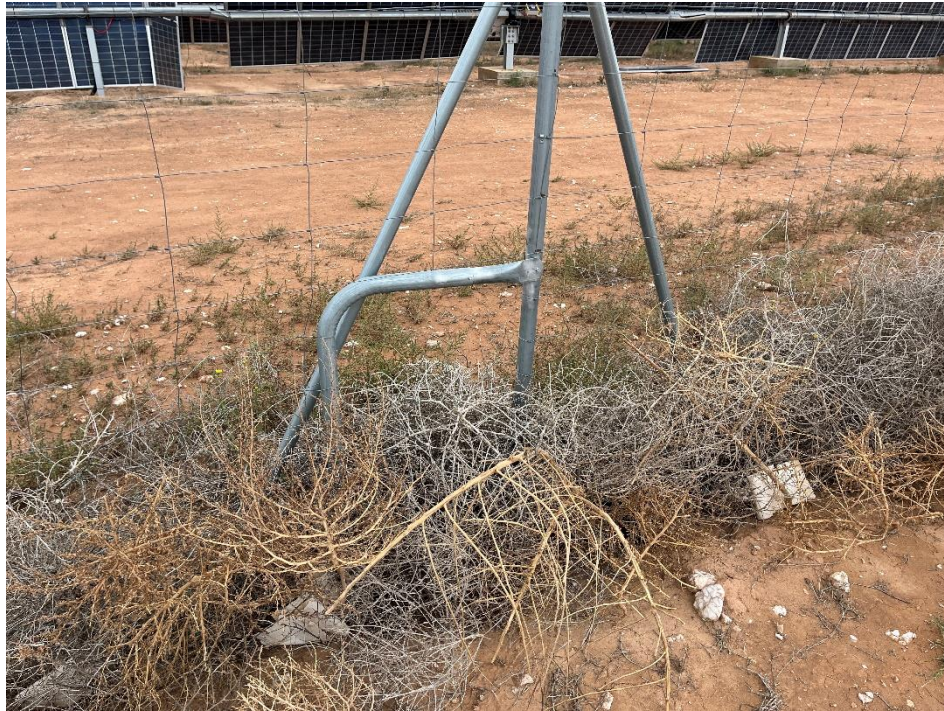
Fotografía 1: Acumulación de capitana en paso de fauna dificultando la permeabilidad
