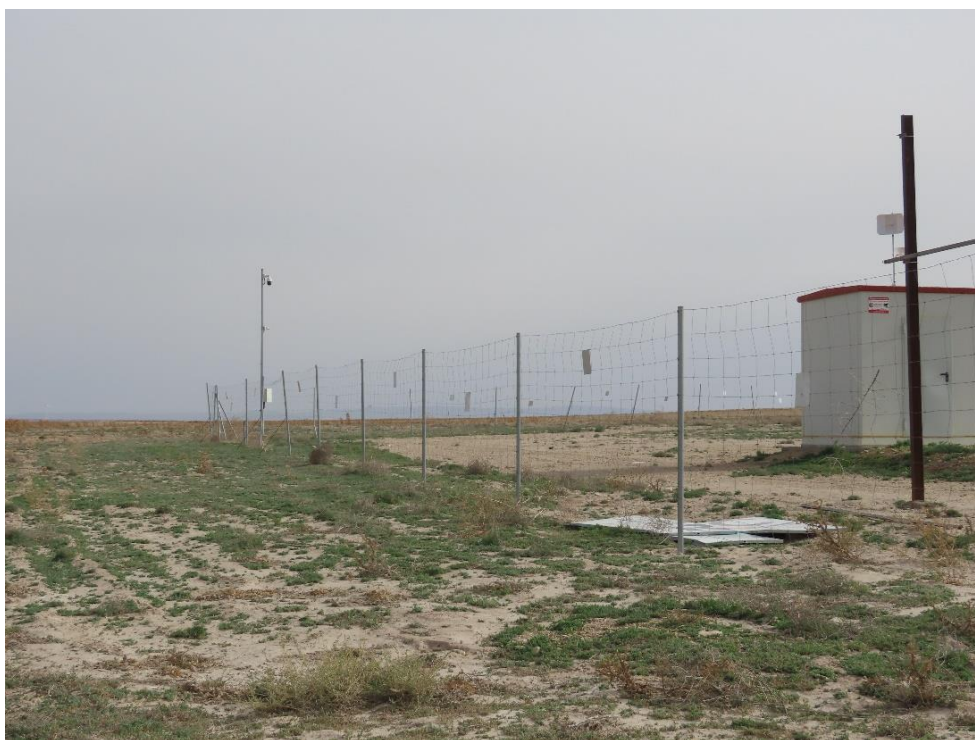
Fotografía 7: Entorno del vallado perimetral
