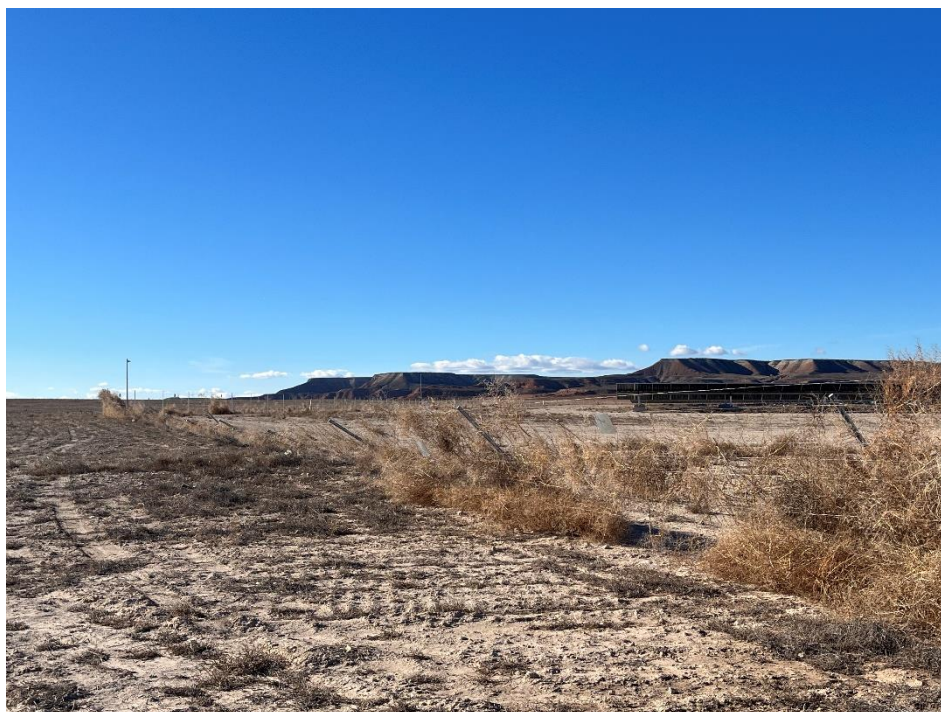
Fotografía 4: Vallado perimetral vencido por la acumulación de capitanas
