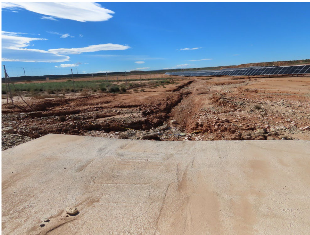
Figura 6. Hormigón en un vial de San Miguel A
