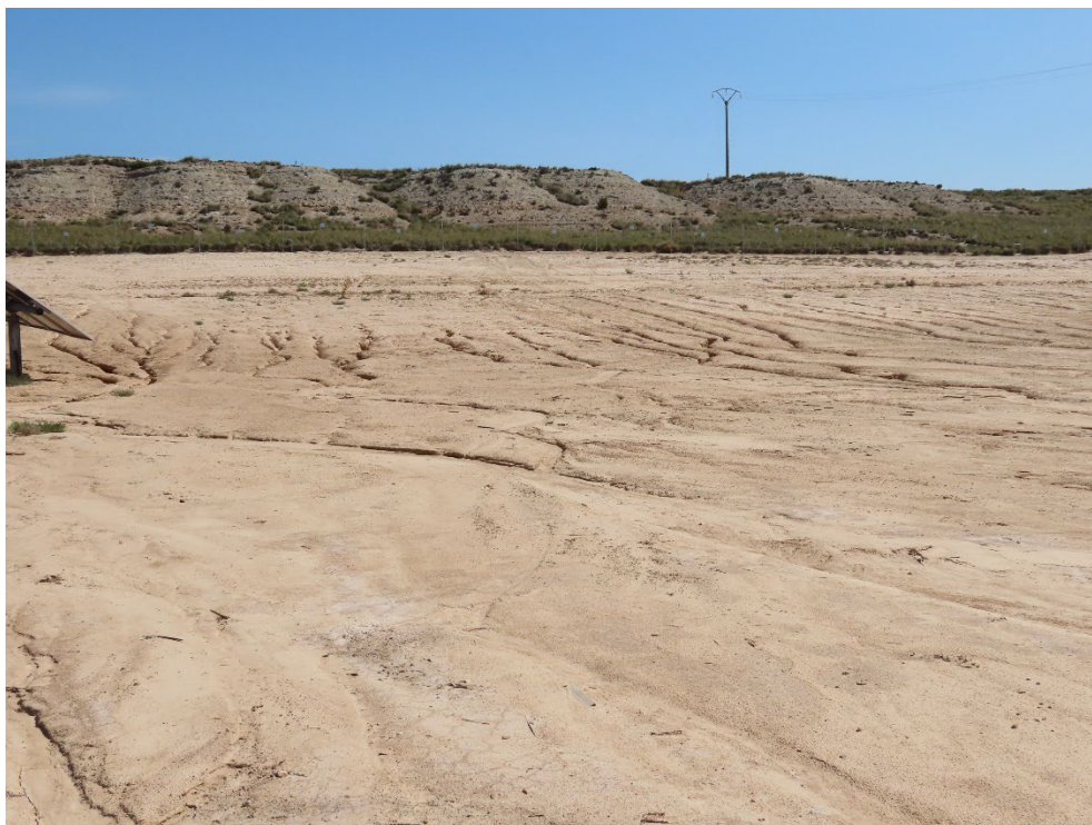
Figura 3. Efectos erosivos (San Miguel A)
