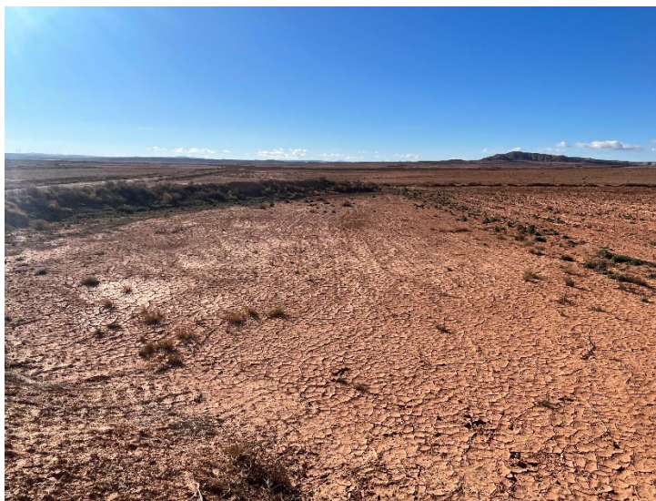
Figura 6 Estado de los balsetes
