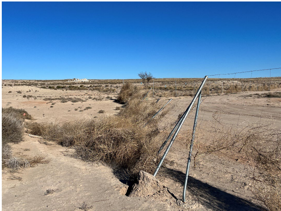
Figura 7 Afección al vallado por acumulación de capitanas
