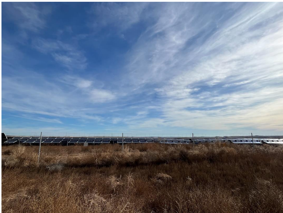
Fotografía 4: Estado de la vegetación natural en el entorno del vallado perimetral
