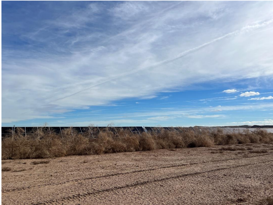
Fotografía 3: Acumulación de capitans en el vallado perimetral en el período septiembre- noviembre 2023
