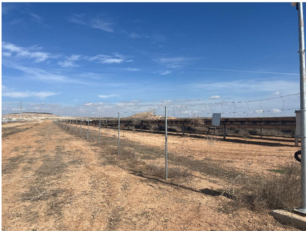
Fotografía 6: Entorno del vallado perimetral una vez retirada la acumulación de capitana
