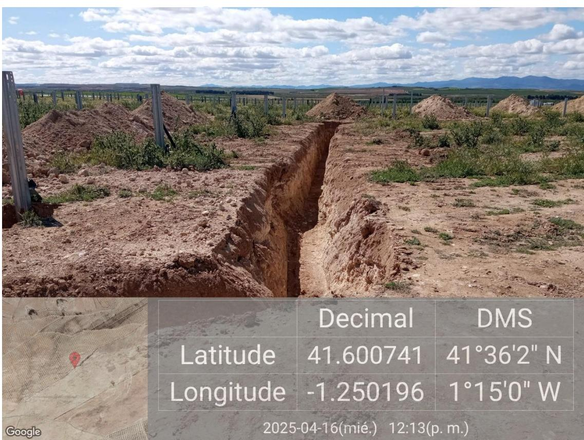
Ilustración 9. Apertura de zanjas.
