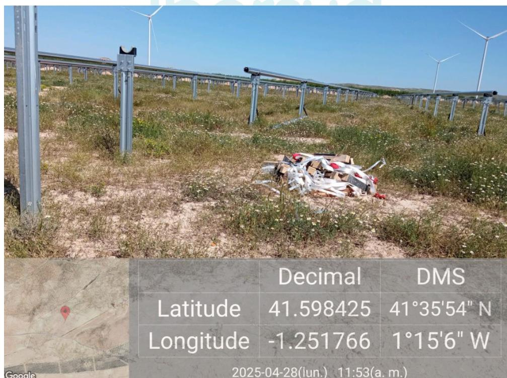
Ilustración 11. Acopio de residuos sin clasificar.
