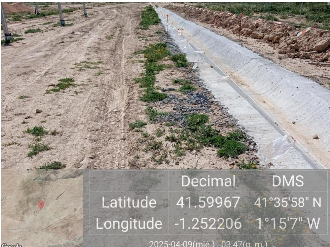
Ilustración 8. Restos de hormigón en las canaletas hormigonadas de la zona sur.
