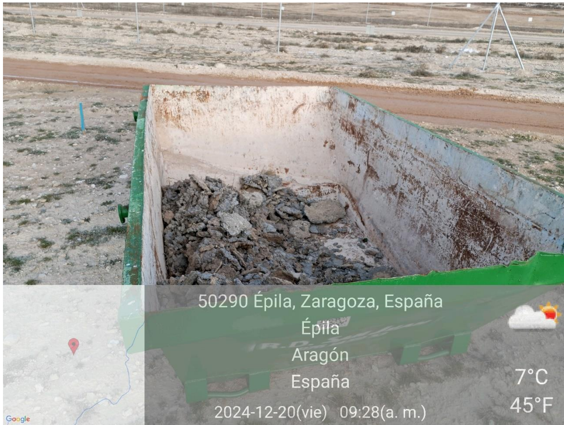
Ilustración 7. Contenedor de residuos de construcción con los restos de hormigón retirados de la planta.
