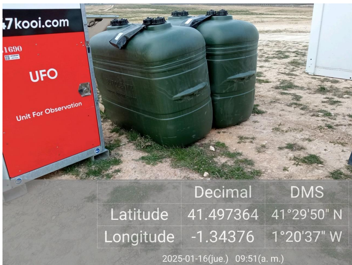
Ilustración 8. Combustible sin medidas antiderrames, aunque sin vertidos de ningún tipo.
