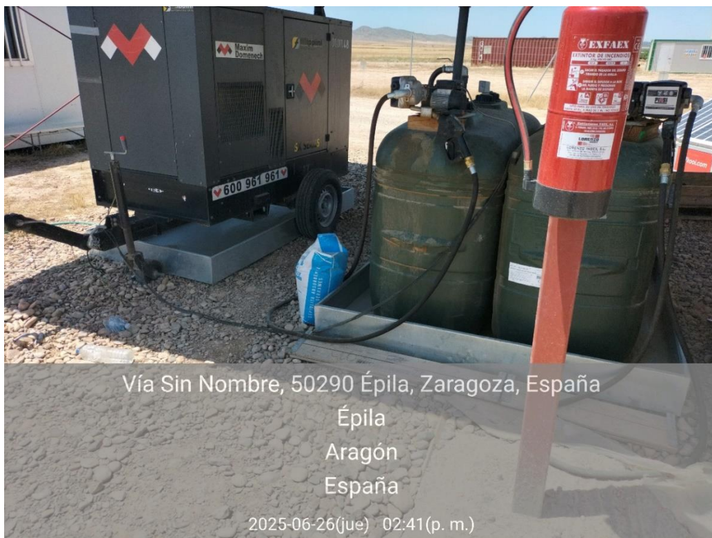
Ilustración 12. Uso de cubetas bajo el generador y bidón de combustible.
