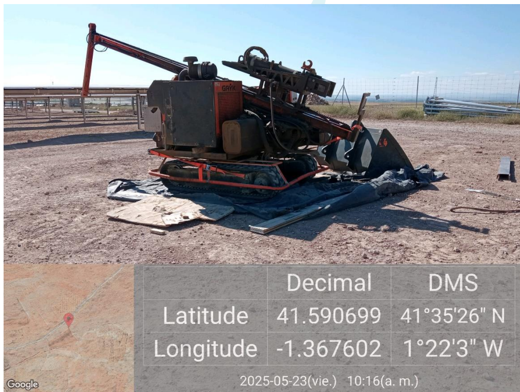
Ilustración 8. Máquina sobre lona para prevenir vertidos por pérdidas al suelo.
