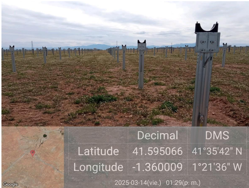
Ilustración 12. Hincado sin decapado previo y sin residuos de construcción.
