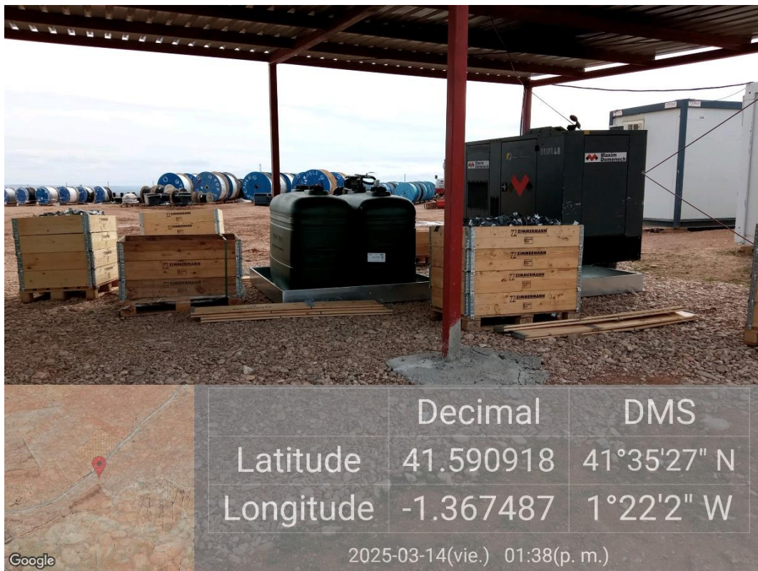
Ilustración 10. Medidas para prevenir posibles vertidos en la zona acondicionada para el acopio de generadores.
