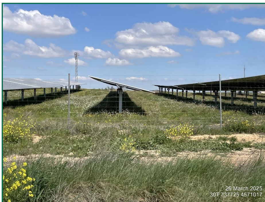
Fotografía 1. Vegetación entre placas actualmente.
