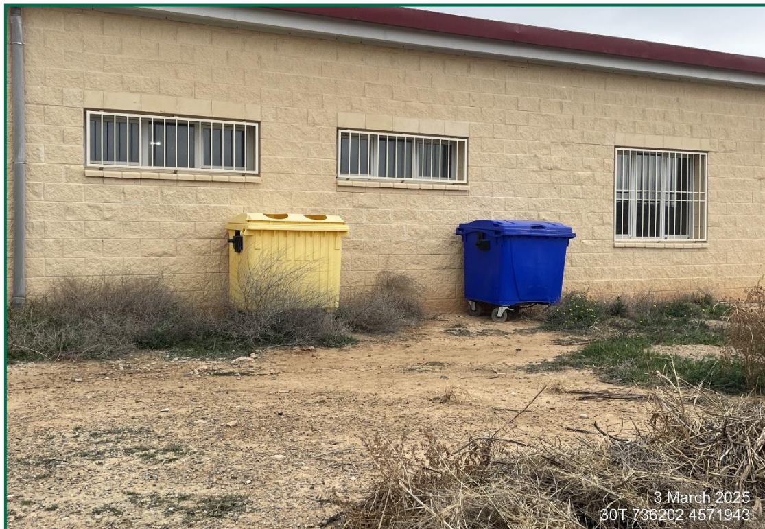
Fotografía 33. Contenedores de residuos no peligrosos en exterior de la subestación.
