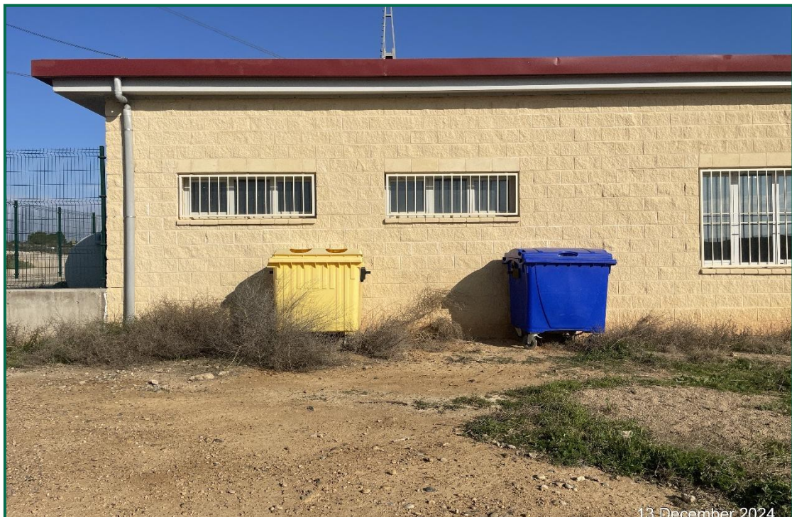
Fotografía 47. Contenedores de residuos no peligrosos en exterior de la subestación.
