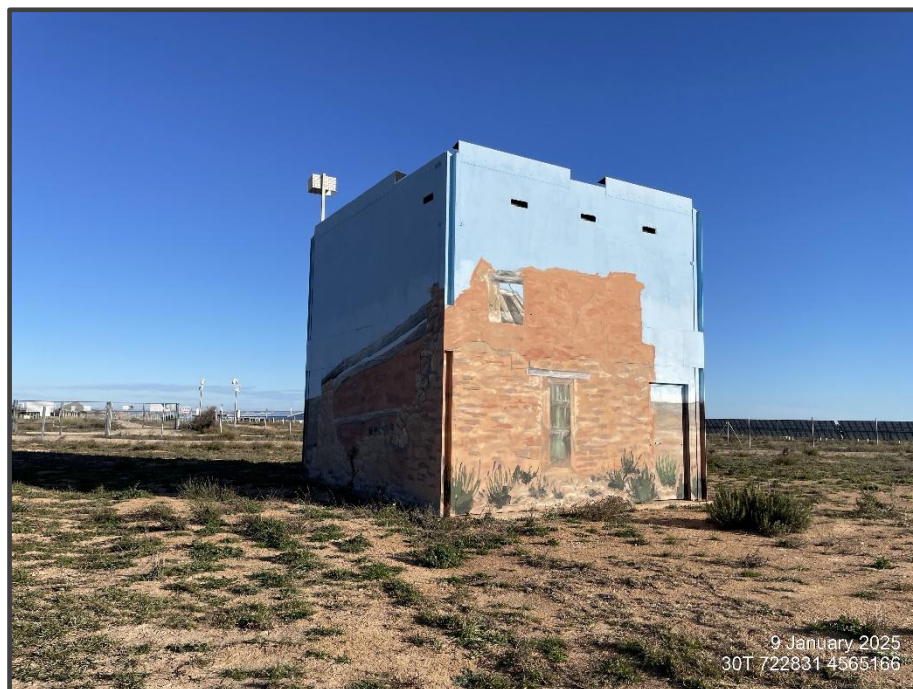
Fotografía 27. Exterior del primillar, pintado.
