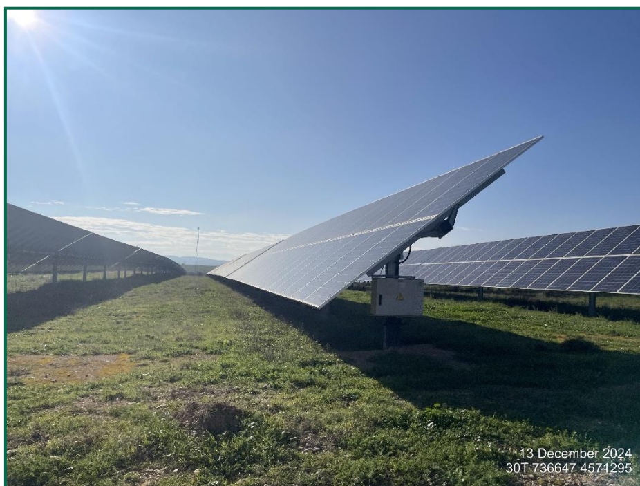
Fotografía 1. Vegetación entre placas actualmente.
