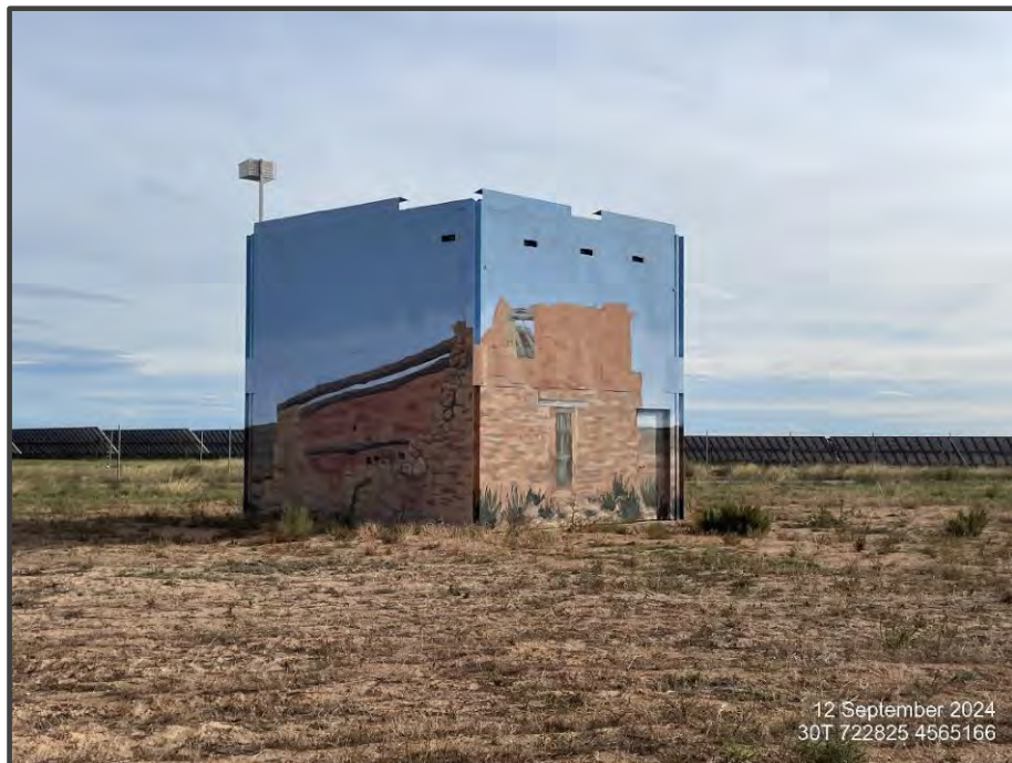
Fotografía 17. Exterior del primillar, pintado.
