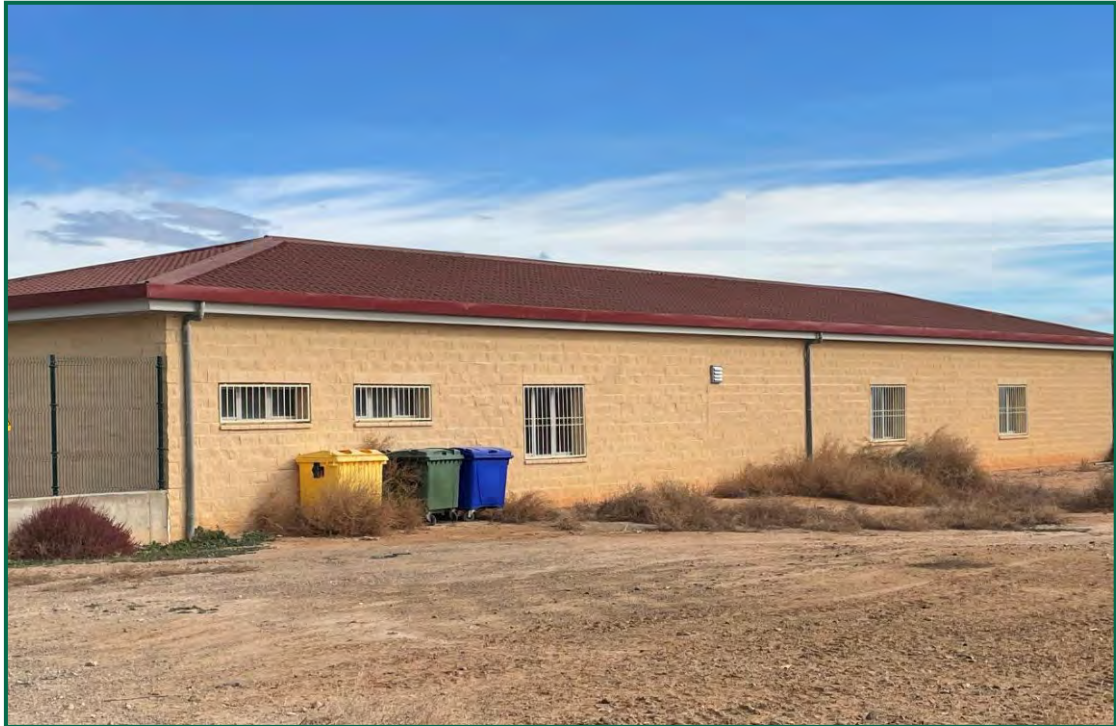
Fotografía 38. Contenedores de residuos no peligrosos en exterior de la subestación.
