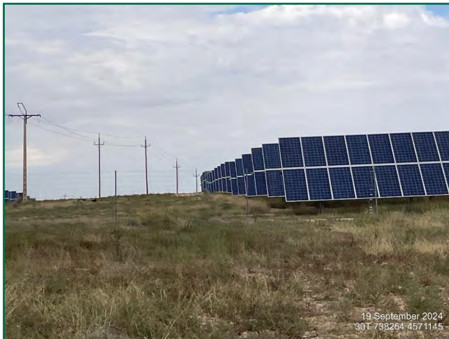
Fotografía 1. Vegetación entre placas actualmente.
